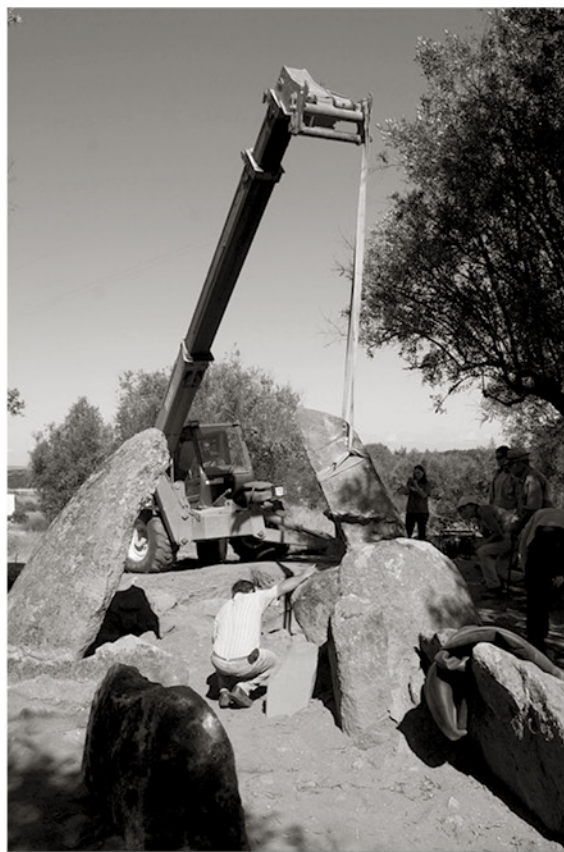
Fase de remontagem de um dos esteios fracturados da câmara
