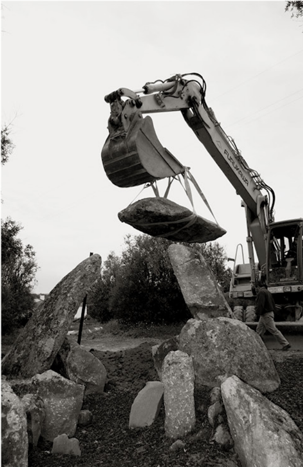
Remontagem do chapéu do monumento
