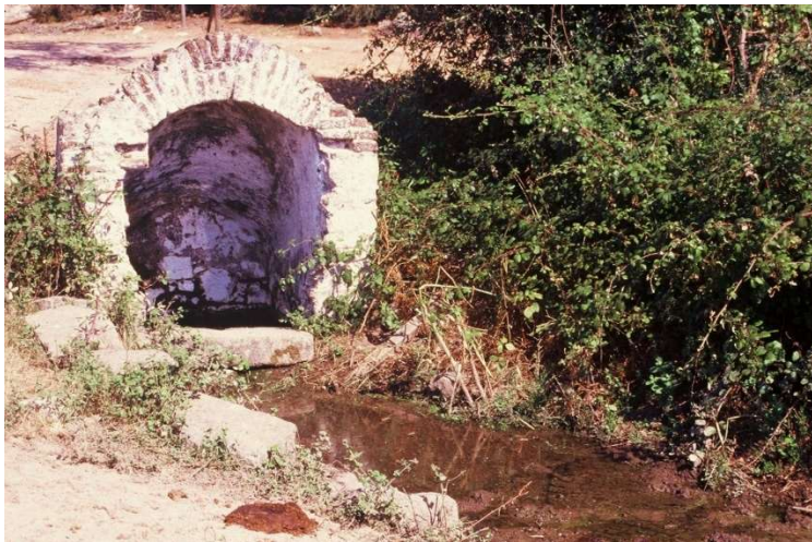
Figura 52 - Fonte da Alverca (Herdade da Mitra de Valverde). Poço/nascente protegido por estrutura em abobadilha de tijolo (Autor: José M. de Mascarenhas, 1999).
