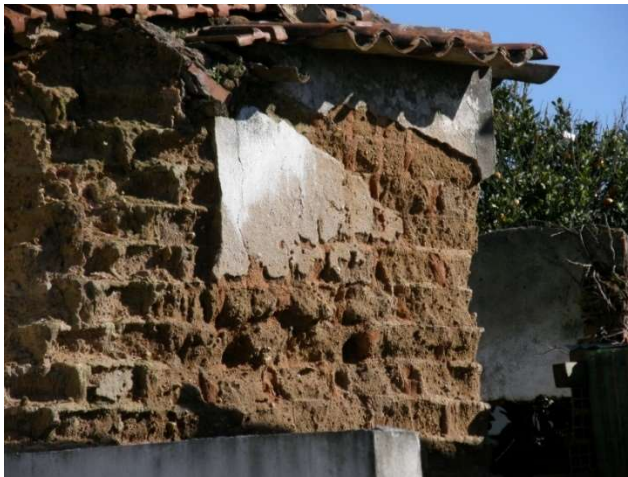
Figura 42 - Muro em adobe, em Ferreiros, Moita (Autor: José M. de Mascarenhas, 2011).
