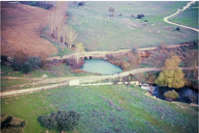
Figura 58 - Barragem do Conde, na Herdade da Fonte Boa do Degebe (Autor: José M. de Mascarenhas, 1985).
