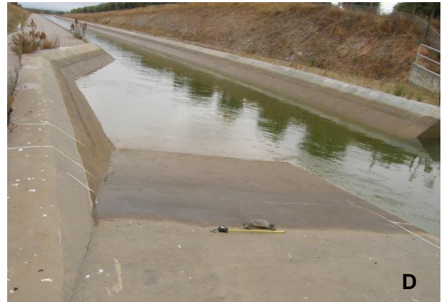
Fig. 2: Overpass (A), culvert (C), fence (D) and wildlife escape ramp (D) at the Alqueva irrigation canals.
