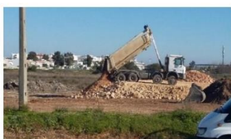
Trabalhos de enchimento Janeiro 2017
