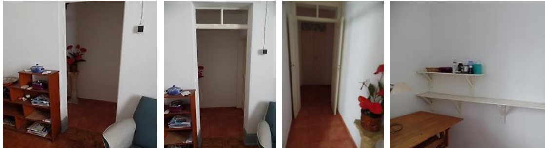
Figs. 214-216 - Passagem da primeira para a terceira sala do atelier , cuja porta se vê ao fundo, na 3ª imagem. Pode observar-se um corredor antes inexistente com uma parede à direita - última imagem - espaço retirado à segunda sala. Fonte: fotos de Maria Santana.
