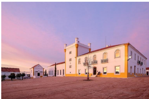
Figura 14. Vista panorâmica da casa principal.
