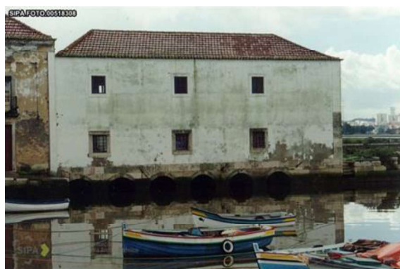
Figura 1 – Moinho de Maré em Alhos Vedros - IPA.00006164, s/ data. In SIPA 2011
