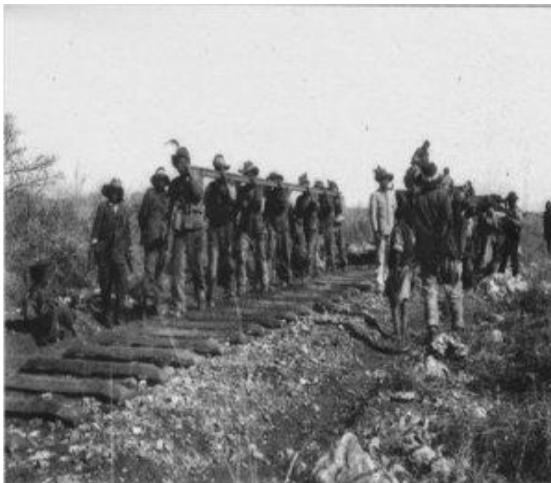
Figure 11 : Construction de la première ligne du chemin de fer au Cameroun par les Allemands entre 1906 et 1910.
