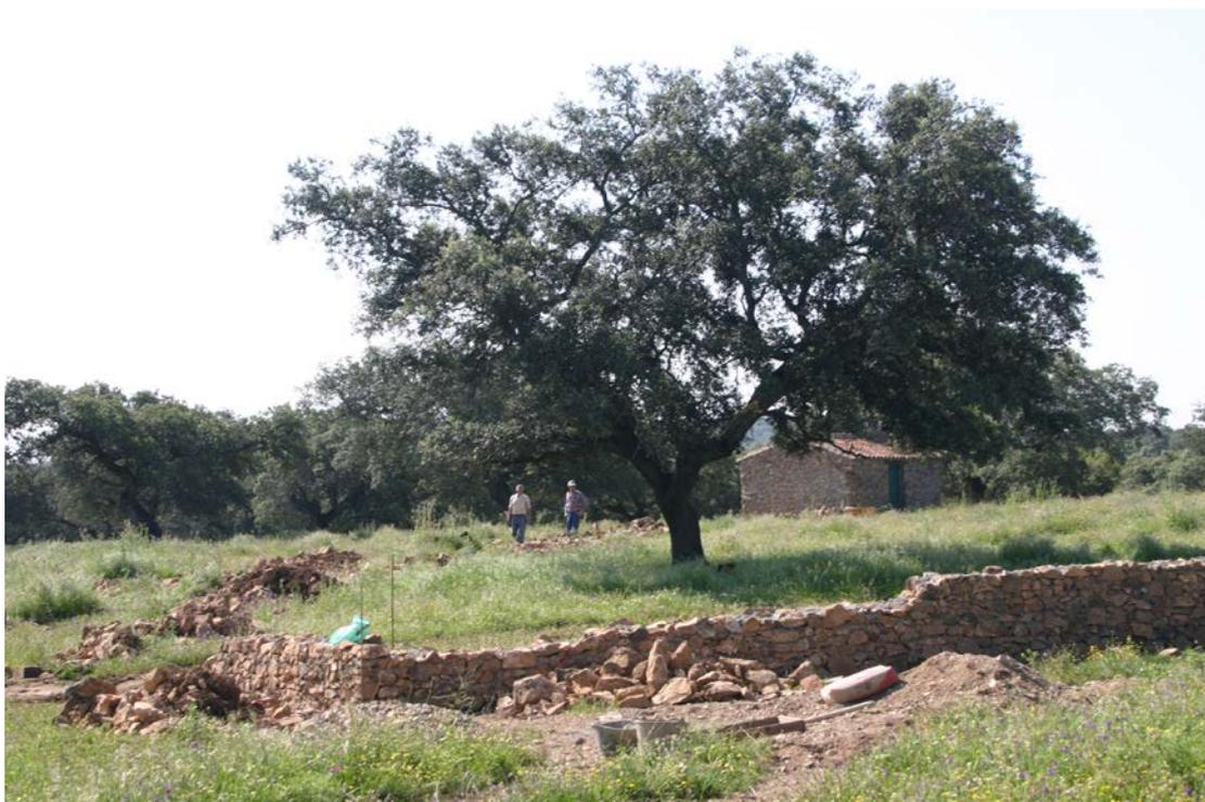
*Figura 67. Proceso construcción muro piedra seca en la dehesa Valdelahaba. (Elaboración propia)*
