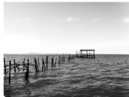
FIGURA 071 | Cais Palafítico da Carrasqueira - Última estrutura do cais.
