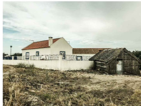
FIGURA 047 | Cabana agregada a uma construção de alvenaria, em elevado estado de degradação. Possanco, Carrasqueira.
