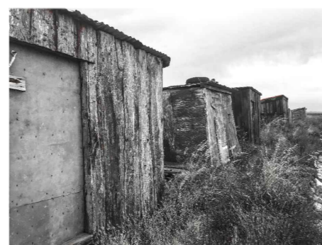
FIGURA 073 | Primeiros abrigos a serem construídos anexos ao cais.
