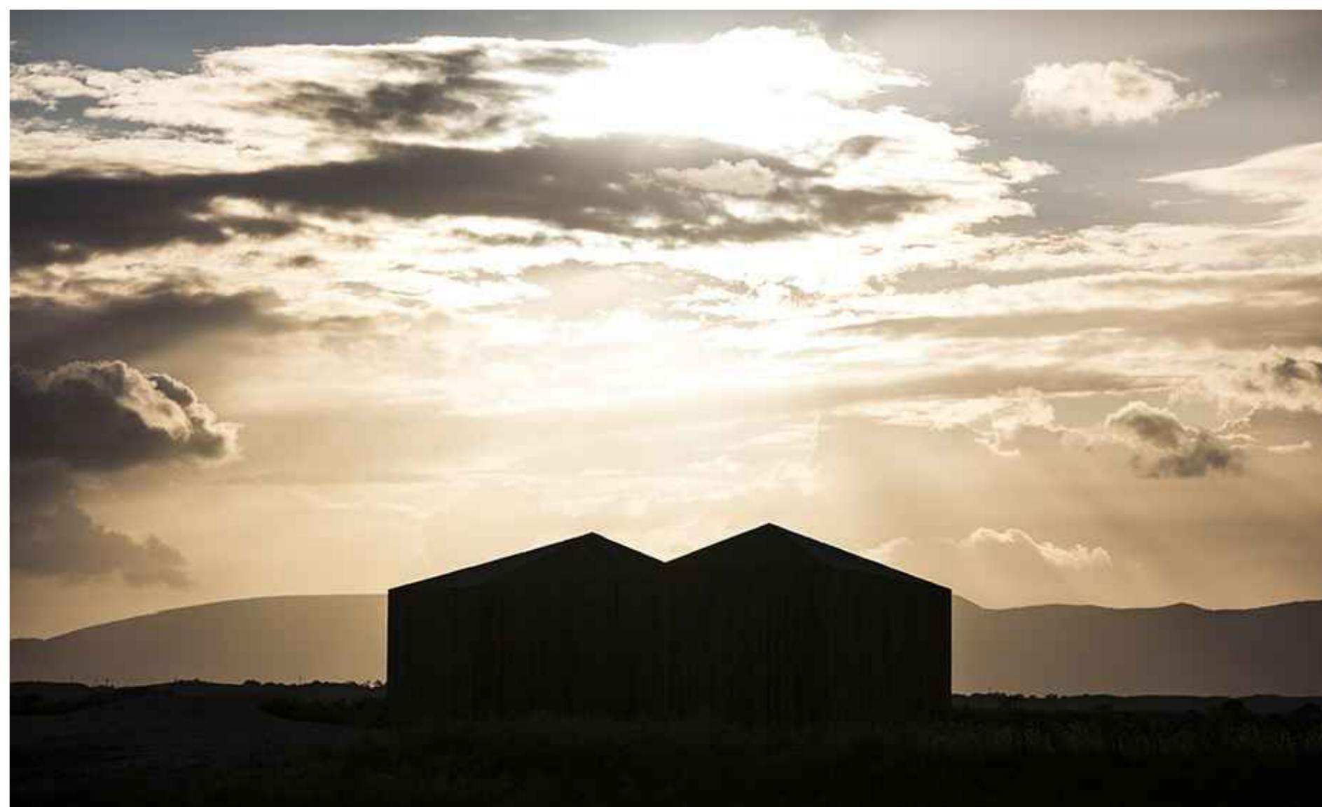
FIGURA 161 | Cabanas - Vista exterior.
