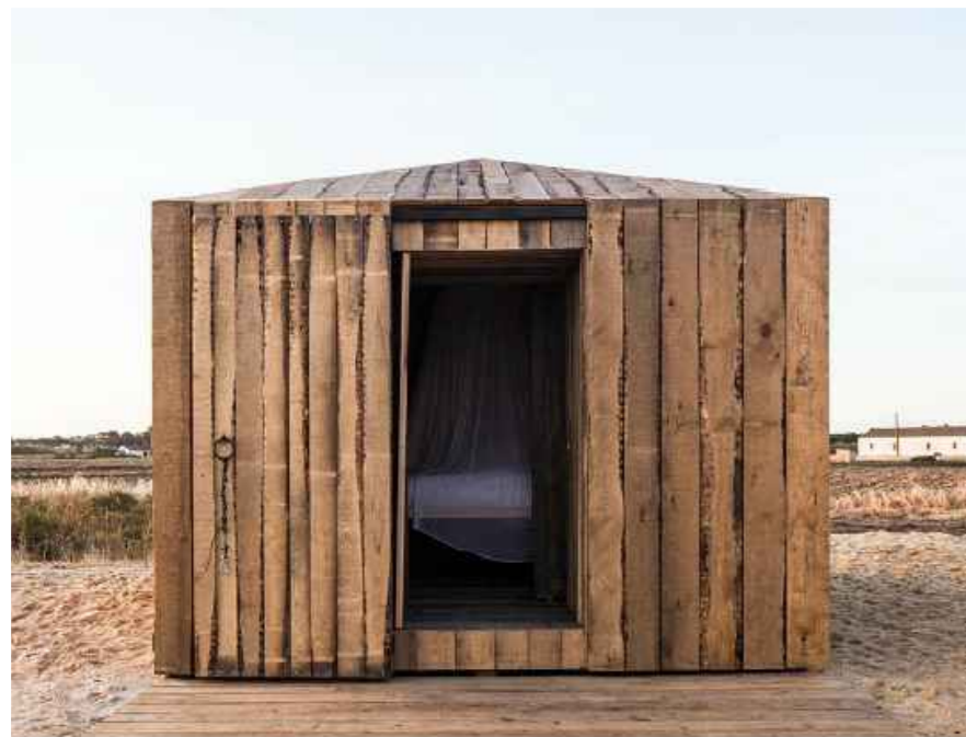
FIGURA 157 | Cabana Quarto - Vista exterior.
