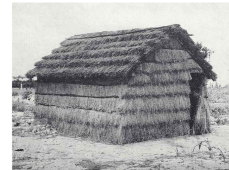
FIGURA 040 | Abrigo de planta quadrangular - Tipo cobertura e parede diferenciados.
