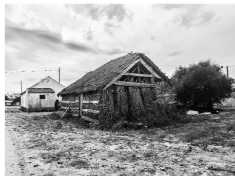
FIGURA 067 | Cabana bastante degradada com desprendimento das tábuas e do colmo. Carrasqueira, Comporta.
