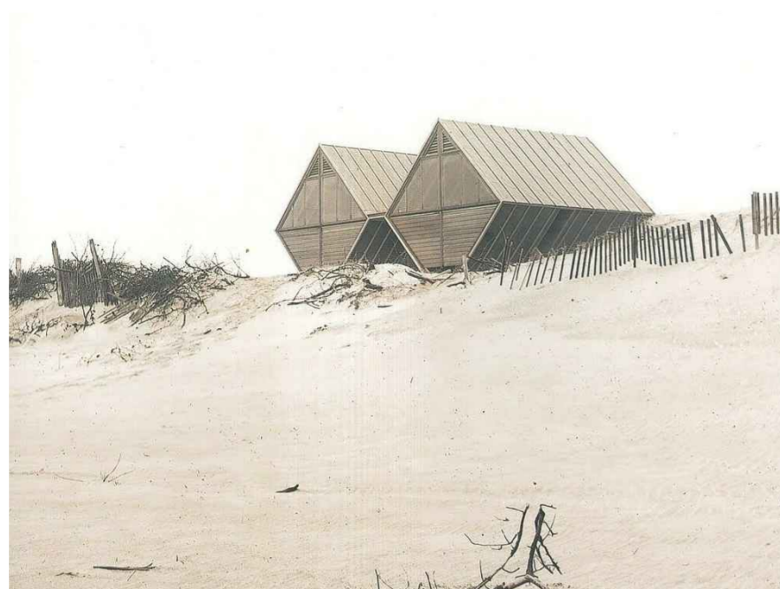
FIGURA 113 | Pearlroth House - Vista exterior.
