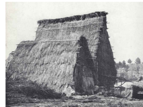
FIGURA 039 | Abrigo de planta quadrangular - Tipo cobertura-parede.
