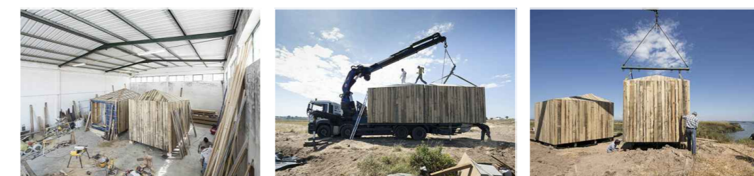
FIGURA 135, 136 e 137 | Construção, deslocação e implantação das cabanas no local.
