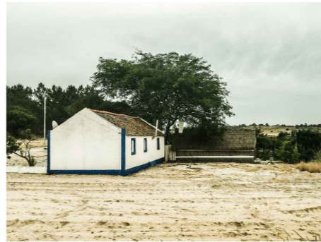
FIGURA 046 | Cabana agregada a uma construção de alvenaria. Possanco, Carrasqueira.
