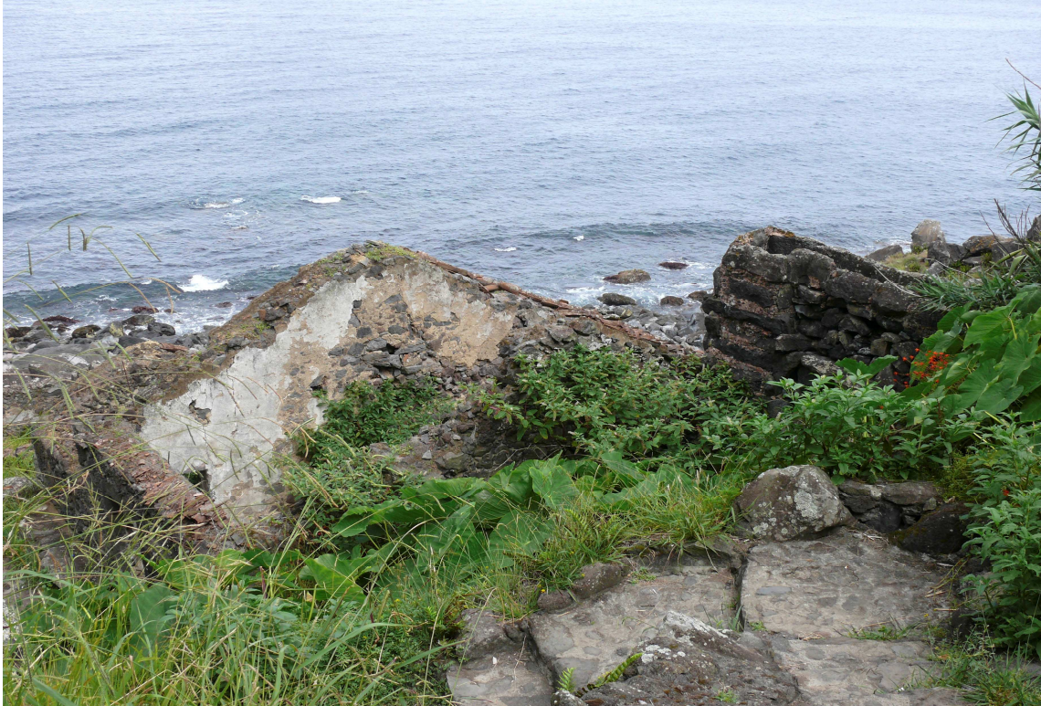
Cubo de um dos moinhos dos Callhambazes. Vêem-se, abaixo, as paredes, já sem tecto, do moinho.
