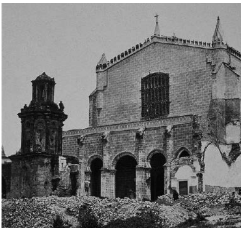
Fig. 79. FOTOGRAFIA IGREJA DE S. FRANCISCO, (1873) Fonte: SIPA (2018).
