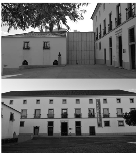
Antigo Palácio da Inquisição, exterior Fonte: fotografia tirada pela autora, 2018
