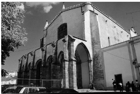
Fig. 80. FOTOGRAFIA IGREJA DE S. FRANCISCO, (2002) Fonte: SIPA (2018).
