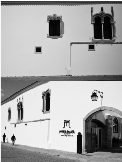
Antigo Palácio dos Condes de Basto, exterior Fonte: fotografia tirada pela autora, 2018
