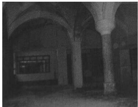
Fig. 51. FOTOGRAFIA DO ANTIGO CONVENTO DE SÃO DOMINGOS , Corpo principal, rés-do-chão(2004 anterior à intervenção)
