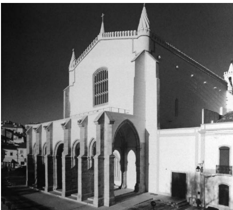
Fig. 84. FOTOGRAFIA IGREJA DE S. FRANCISCO , (2015 após as obras de intervenção) Fonte: Dias, A. (2015) Igreja de S. Francisco reabilitação. (pp.51) (2018).
