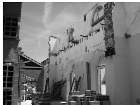
Fig. 92. FOTOGRAFIA ANTIGO PALÁCIO DOS SEPULVEDAS (2009 durante as obras de intervenção) Fonte: http://www.termoprojecto.pt/portfolio/hotel-mar-de-ar-aqueduto-evora (2018).
