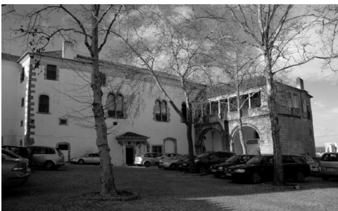
Fig. 70. FOTOGRAFIA PALÁCIO CONDES DE BASTO , (Após a intervenção dos anos 50 do séc.XX) Fonte: SIPA(2018).
