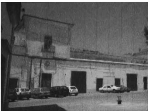
Fig. 49. FOTOGRAFIA DO ANTIGO CONVENTO DE SÃO DOMINGOS , Fachada principal (2004 anterior à intervenção)
