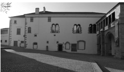
Fig. 72. FOTOGRAFIA PALÁCIO CONDES DE BASTO , 2018 Fonte: Fotografia tirada pela autora.
