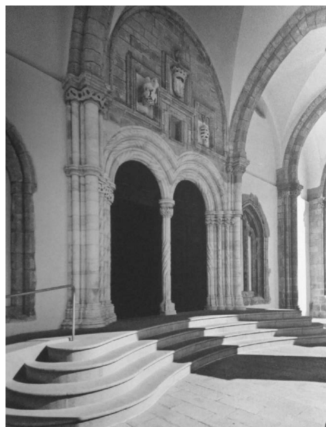
Fig. 86. FOTOGRAFIA IGREJA DE S. FRANCISCO, (2015 após as obras de intervenção)
