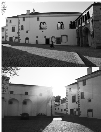
Antigo Palácio dos Condes de Basto, exterior Fonte: fotografia tirada pela autora, 2018
