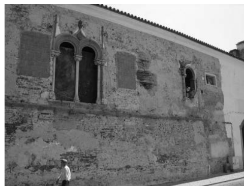
Fig. 91. FOTOGRAFIA ANTIGO PALÁCIO DOS SEPULVEDAS (2009 durante as obras de intervenção) Fonte: http://www.termoprojecto.pt/portfolio/hotel-mar-de-ar-aqueduto-evora (2018).
