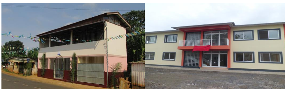
Figura nº 1: Mercado de peixe na localidade de Santana e construção de nova sede da Direcção das Pescas
