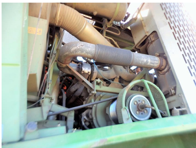
Levantando o painel lateral esquerdo do CF, pode observar-se o tambor da correia de borracha, directamente accionado pela cambota do motor Diesel – Herdade do Casão (TeAM 2016)
