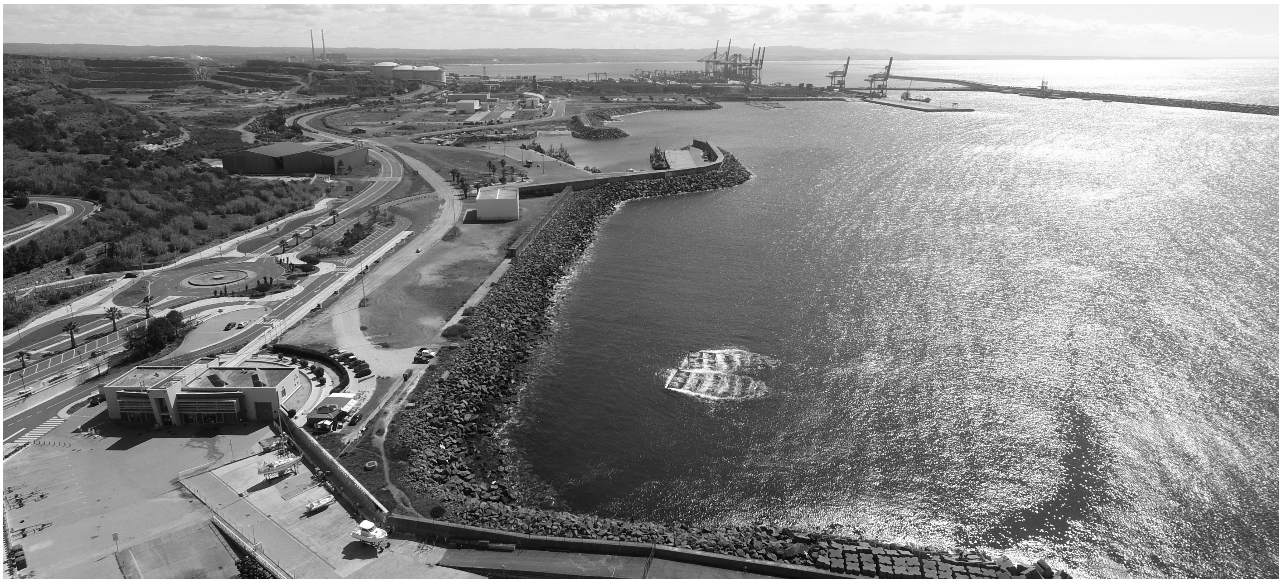
fig. 199 Fotografia aérea do porto de recreio, porto de serviços e ao fundo o porto de contentores, 2016. © Francisco Brito
