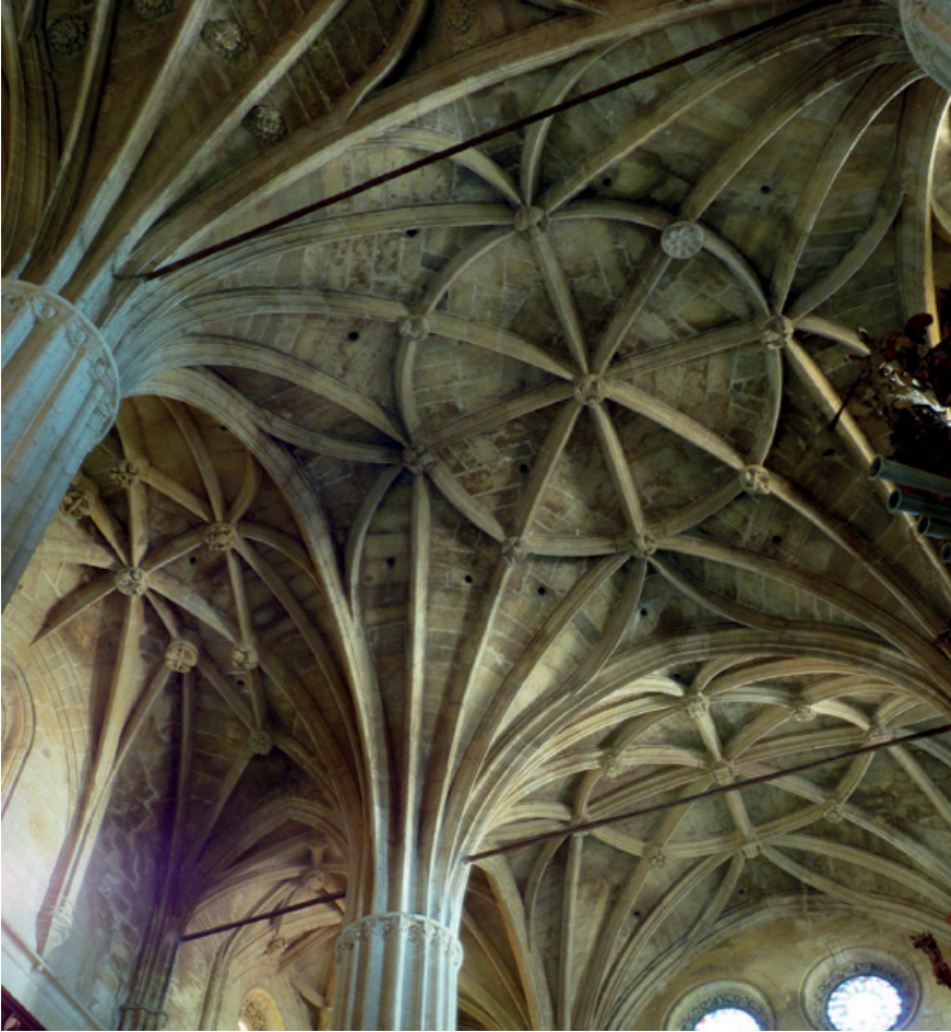
Fig. 2. Arcos de la Frontera. Parroquia de Santa María. Bóveda de la nave central
