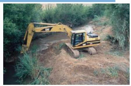
O equipamento e as técnicas utilizadas na intervenção mecanizada na Ribeira (desassoreamento do leito e limpeza da vegetação infestante), tiveram como objectivo a preservação da integridade paisagística do curso de água e a conservação da vegetação fixadora das margens
