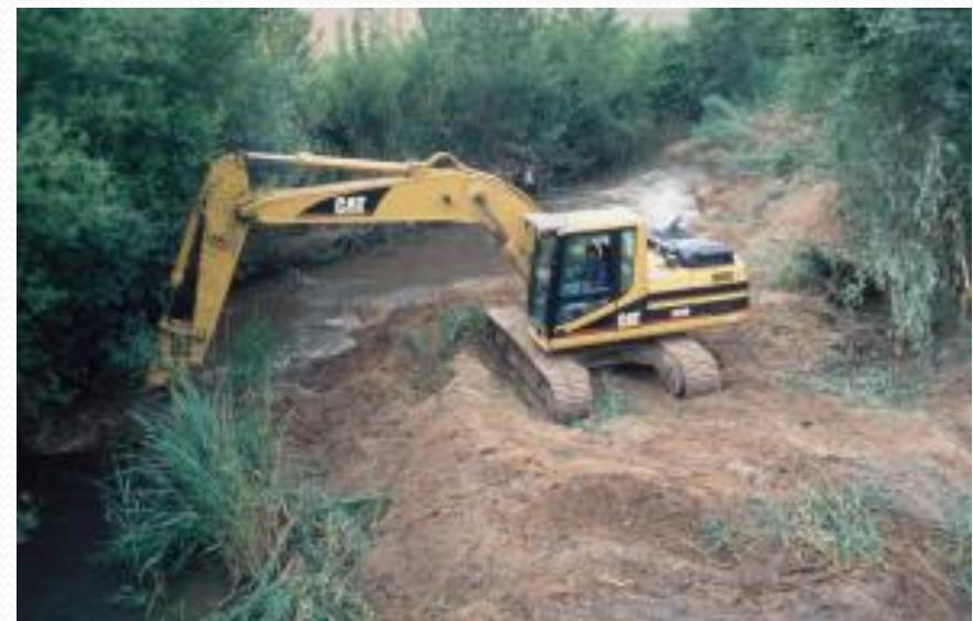
O equipamento e as técnicas utilizadas na intervenção mecanizada na Ribeira (desassoreamento do leito e limpeza da vegetação infestante), tiveram como objectivo a preservação da integridade paisagística do curso de água e a conservação da vegetação fixadora das margens
