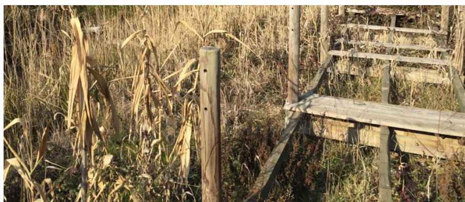
Figura 34 - Registo dos atos de vandalismo nas Salinas da Junqueira. | Fonte: https://www.jornaldeleiria.pt/noticia/proseguem-os-roubos-de-materiais-nas-salinas-da-junqueira-l-5956
