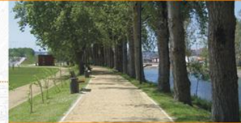
Construção do parque linear e percurso ciclo-pedonal com equipamento de apoio, a montante da Ponte do Arrabalde.
