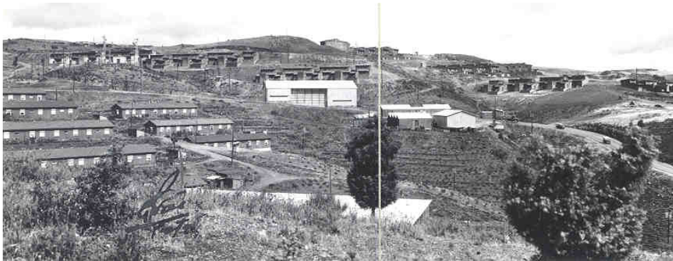
FIG.1.17 | Vista sobre o estaleiro em Bemposta, maioritariamente casas desmontáveis (1960-1964)
