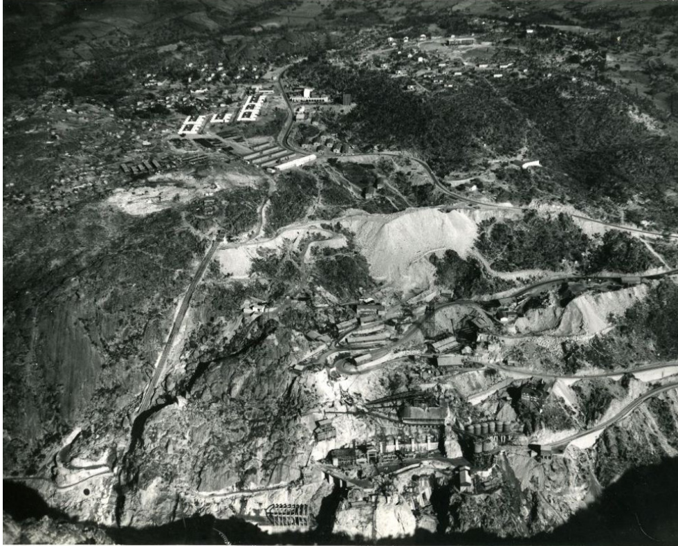
FIG.4.2.| Vista aérea sobre o Aproveitamento Hidroeléctrico de Picote (sem data).
