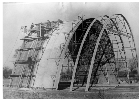
FIG. 5.8. | Grande arco de Ctesiphon (Iraque) FIG.5.9. | Esquema de construção do sistema Ctesiphon, de James Waller.
