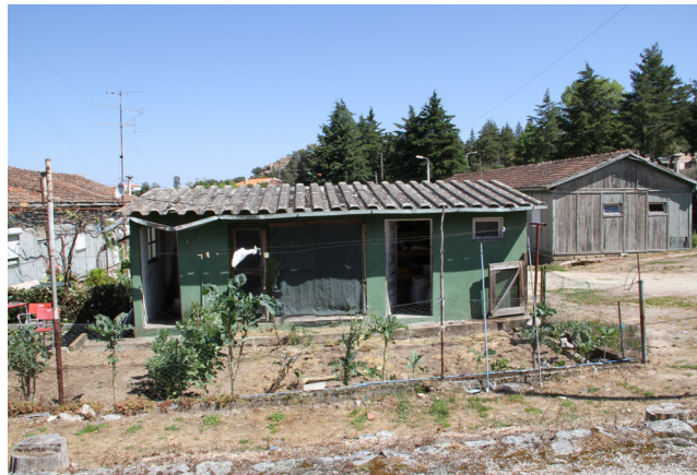
FIG.7.2. | Vista exterior de um anexo de uma Casa para Pessoal Especializado (Abril 2013)
