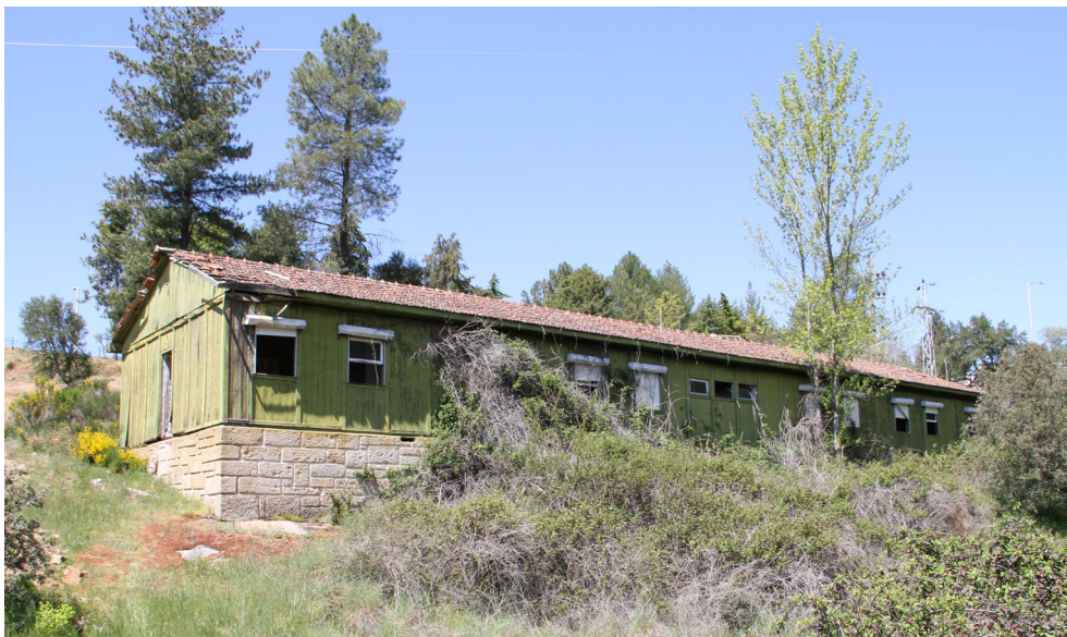
FIG.6.6. | Vista exterior de uma Camarata para Pessoal Especializado Solteiro.
