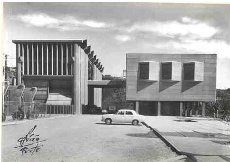
FIG.1.15. | Plano Geral do Bairro e Estaleiro do Aproveitamento Hidroeléctrico de Bemposta (1959).
