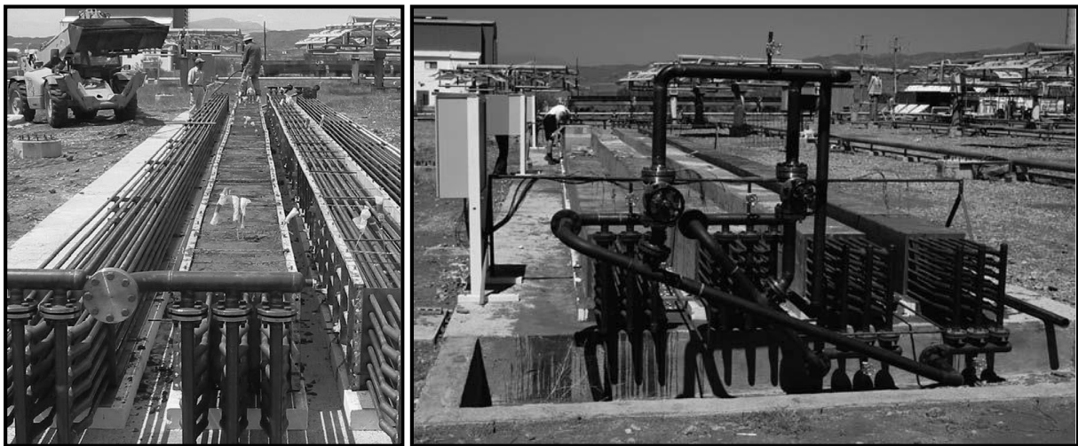
Figura 2: Módulos de armazenamento de energia e sistema de transferência de calor [16].
