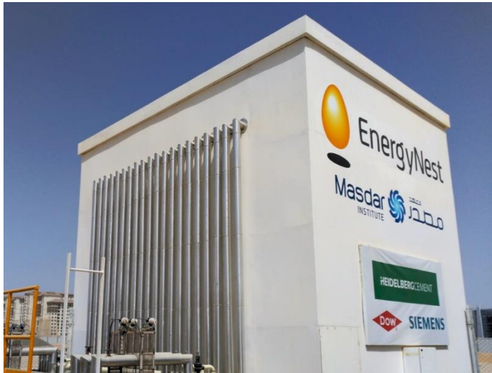
Figura 10: Protótipo do sistema de armazenamento desenvolvido pela empresa energética NEST.
