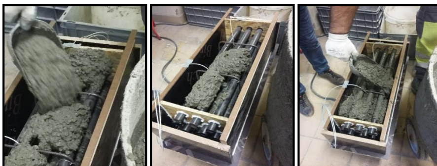
Figura 75: Enchimento do primeiro protótipo com betão C20/25.
