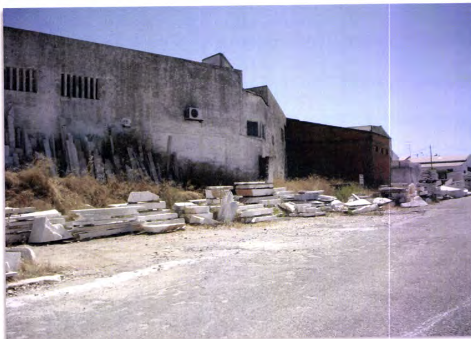
Figura 5.8: Zona industrial de Borba. Dada a falta de condições para a indústria transformadora de mármore, a via pública acaba por fazer parte do layout de produção como parque de produto acabado e subprodutos com a degradação associada.
