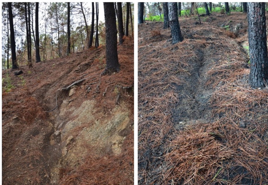
Figura 3. Desenvolvimento de sulcos, concentradores da escorrência e potenciadores de erosão linear, após evento precipitativo intenso (Morreira, Braga).
