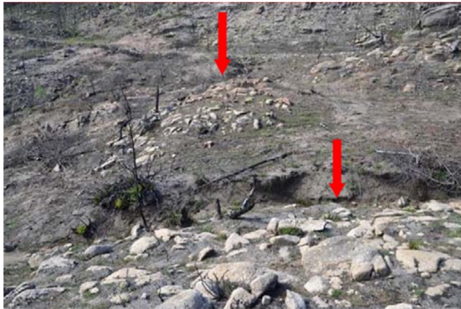
Figura 2. Área selecionada para implementação das medidas de mitigação da erosão em canais.
