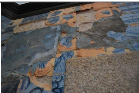
Degradação no topo e algumas zonas com uma massa de coloração acinzentada.
