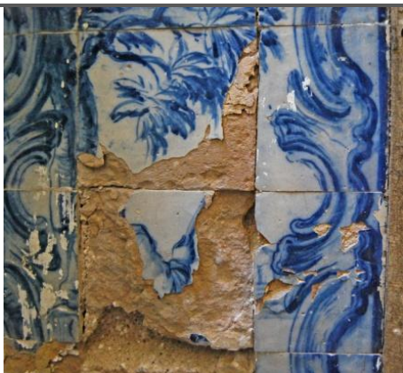
Exfoliação da chacota, destacamento de vidro sem chacota aderente e azulejo muito fraturado.
