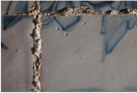
Eflorescências de sais nas juntas ( \uparrow \approx 1,50\text{m} )
