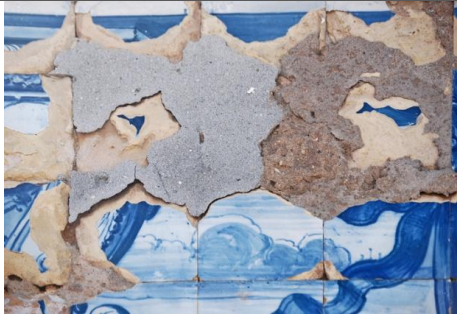
Azulejos de topo com chacota pulverulenta.
