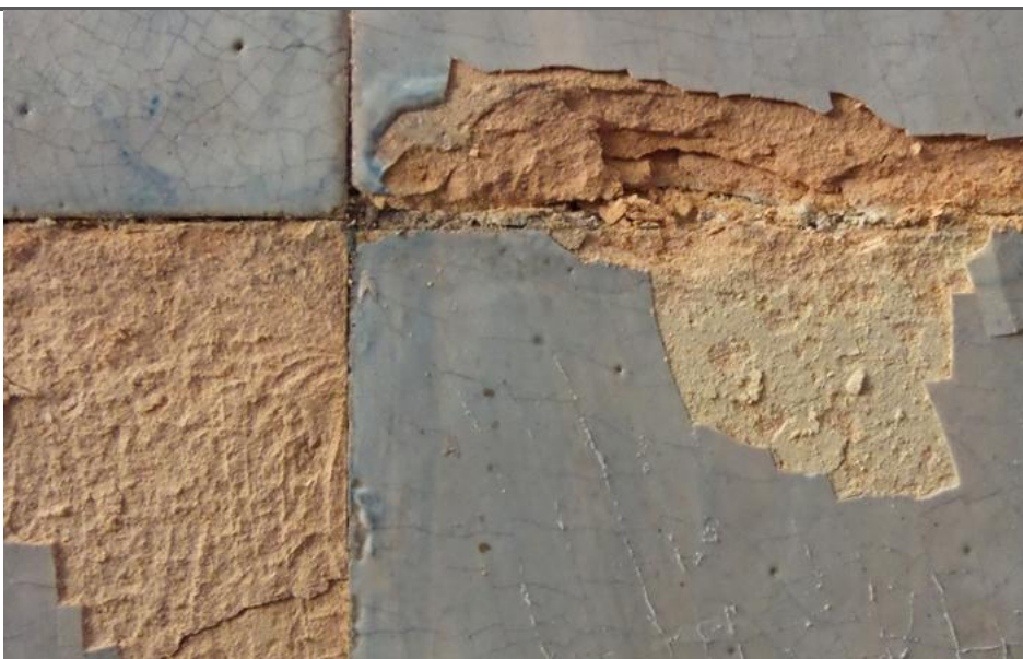
Diferença de coloração nas chacotas: a mais clara e de superfície lisa quando o destacamento do vidro ocorre sem chacota aderente (engobe?); as mais escuras (avermelhadas) com superfície irregular pela perda de vidro com chacota aderente.
