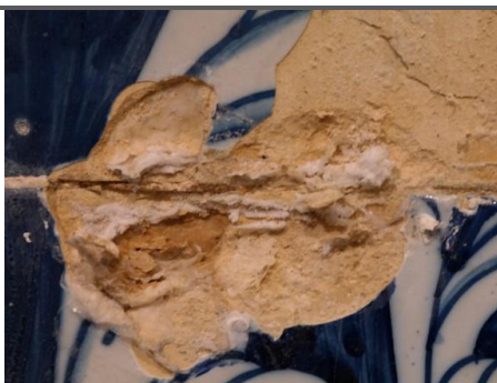
Exfoliação da chacota e eflorescências de sais perto das juntas.
