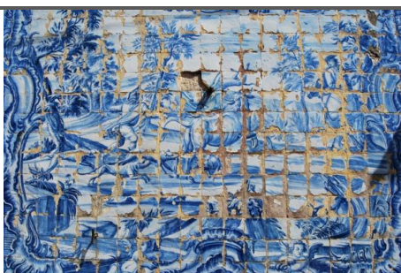
Painel do exterior: Perda de vidro a partir dos vértices e arestas.
