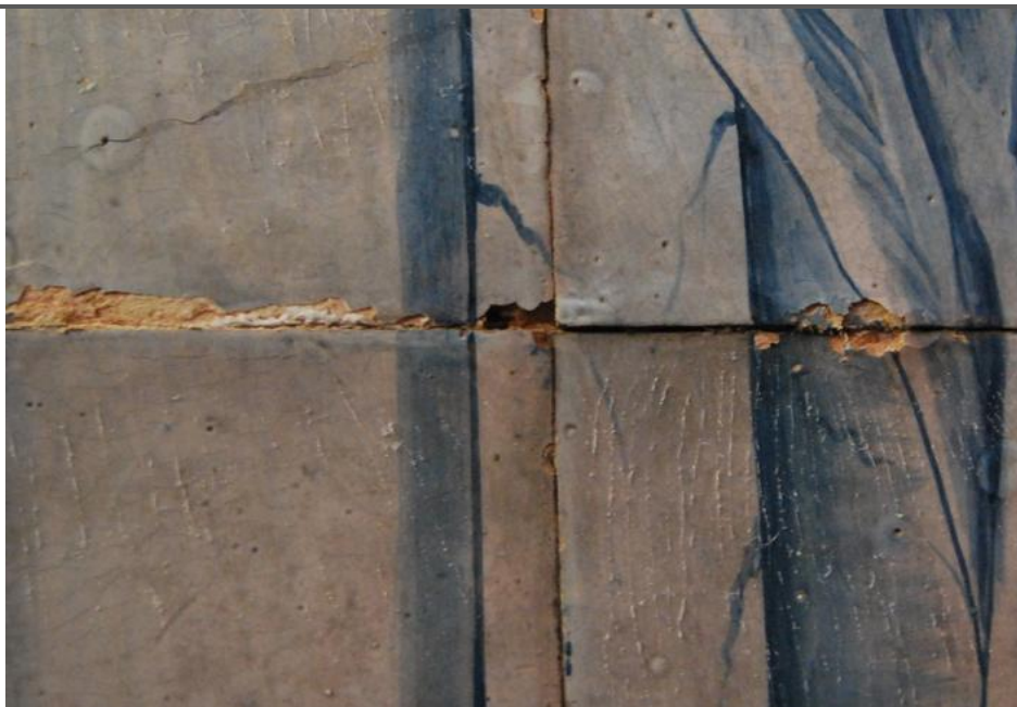
Eflorescências de sais na junta e evidênciação das linhas de craquelé.
