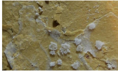
Fragmentos destacados dos azulejos da abóbada. Chacota com cristalizações granulares e em placa.
