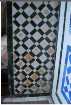
Degradação seletiva dos azulejos com vidrado branco (parede interior).
