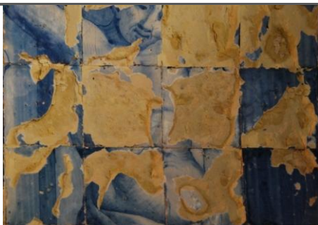
Padrão encontrado no destacamento de placas cerâmicas.
