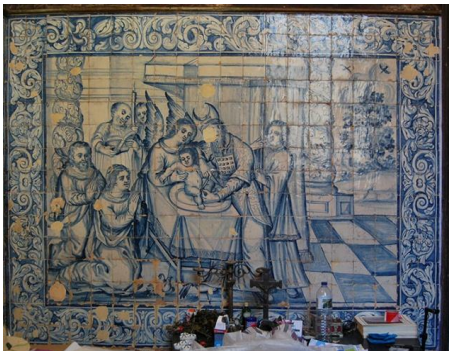
Um dos painéis figurativos com perda de vidrado ao centro.
