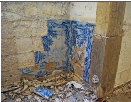
Degradação acentuada na área inferior do painel.
