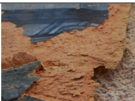
Exfoliação da chacota e destacamento do vidro em mosaicos.
