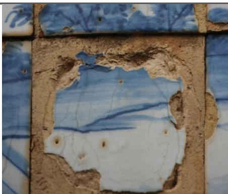
As linhas de craquelé do azulejo mais danificado (direita) prolongam-se para o azulejo limítrofe. A área central sem vidro parece corresponder à maior rede fissural.
