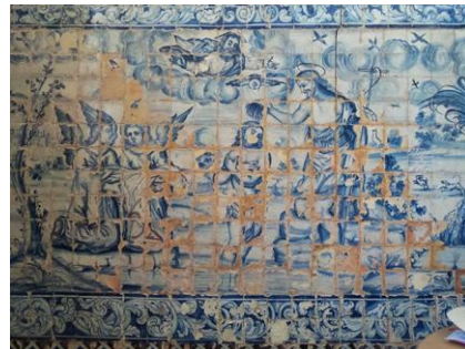
Um dos painéis com degradação predominante nas arestas.
