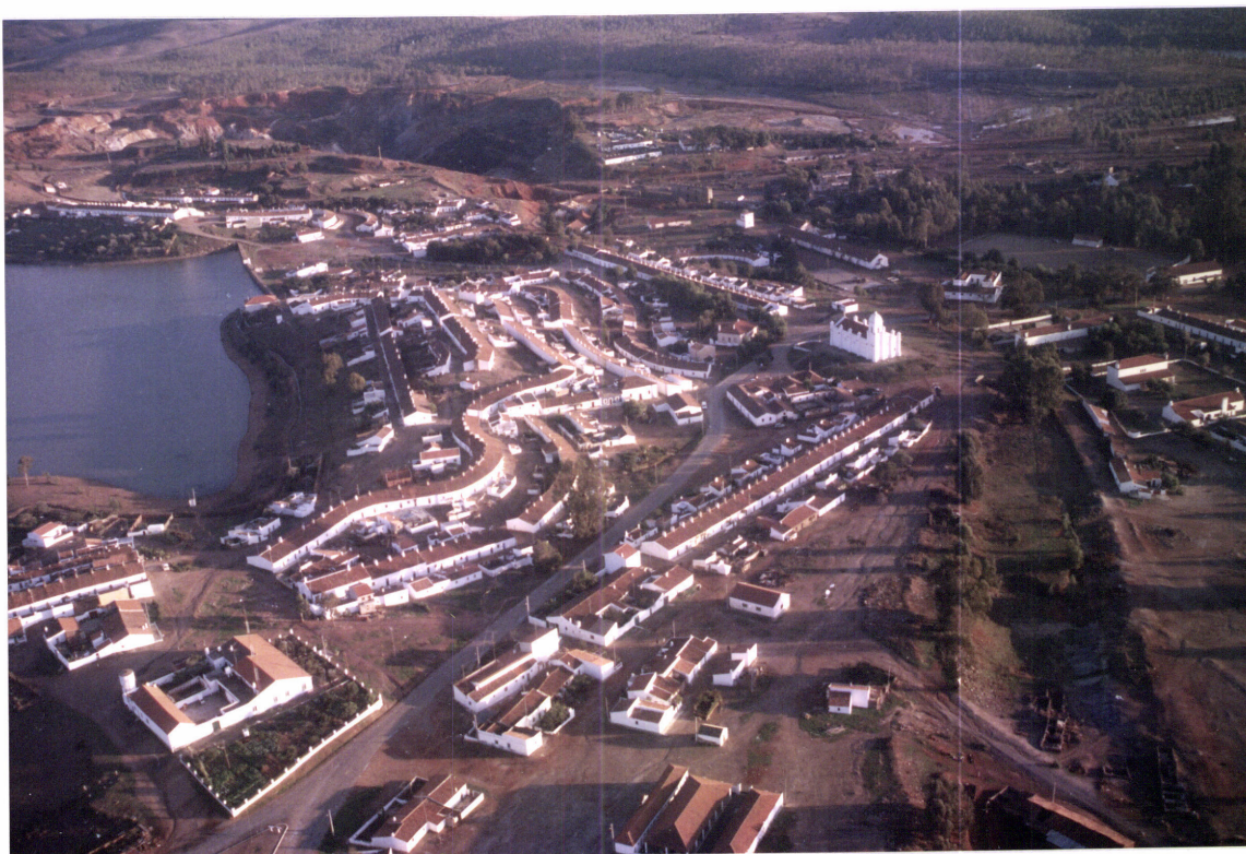
Vista aérea da zona residencial do Bairro dos Mineiros na Mina de S. D omingos.
