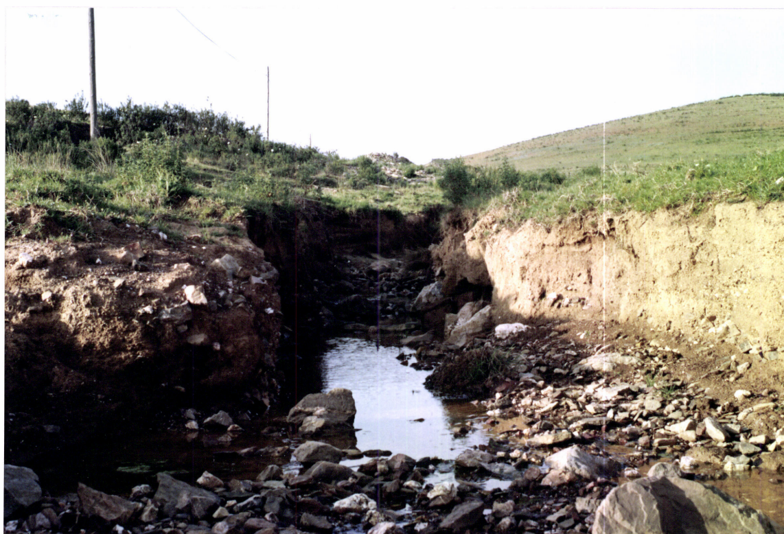
Algumas destas ravinas podem chegar a atingir cerca de 80 cm de profundidade.
