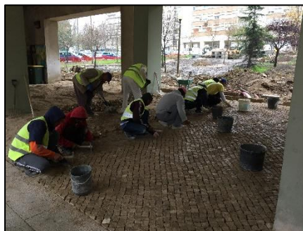
Fig.108- Obra: Execução de Calçada
