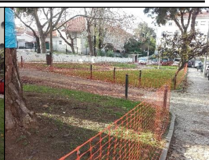
Fig.16- Obra: Vedação de obra
