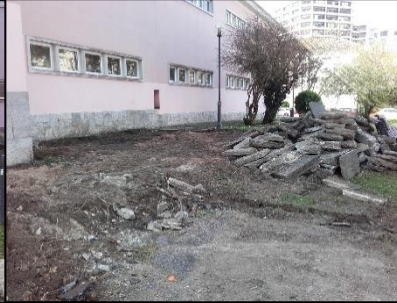
Fig.51- Obra: Remoção Lajes de Granito
