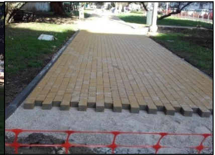
Fig.25- Obra: Colocação de pavimento - pavê
