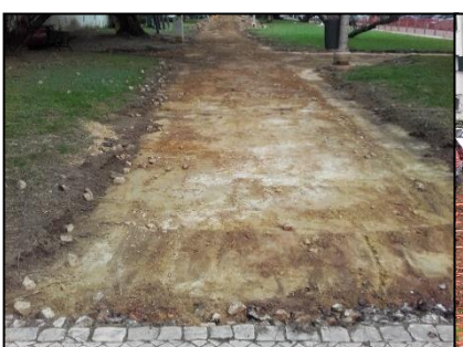
Fig.20- Obra: Execução de caixa de pavimento
