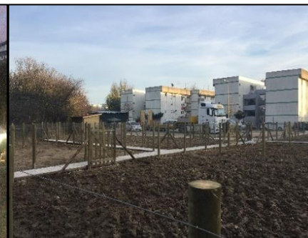
Fig.132- Obra: Colocação de vedações
