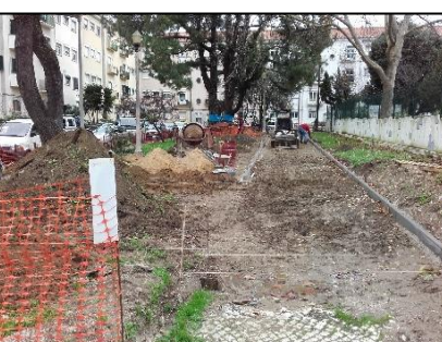
Fig.21- Obra: Colocação de lancil guia de betão
