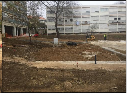
Fig.106- Obra: Marcação de caminhos
