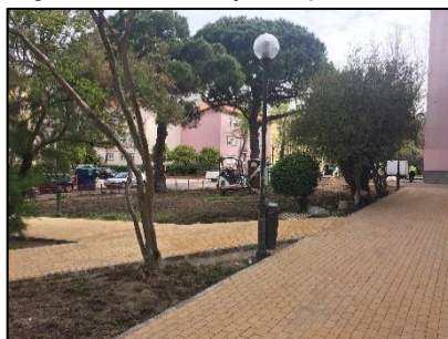
Fig.74- Obra: limpeza de terreno
