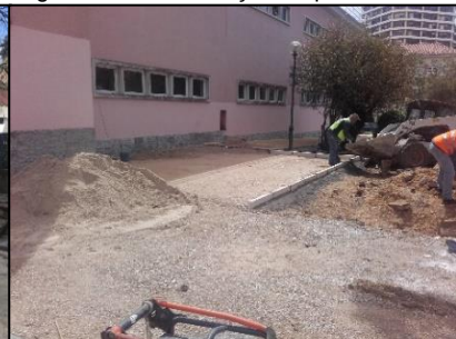
Fig.64- Obra: Colocação de bases
