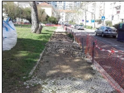
Fig.53- Obra: Remoção de calçada
