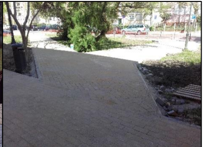
Fig.70- Obra: Colocação de bases
