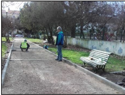
Fig.23- Obra: Colocação de bases de pavimento
