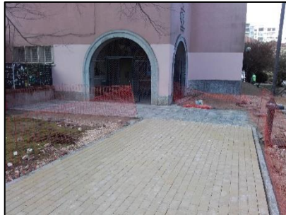
Fig.68- Obra: Colocação de pavimento
