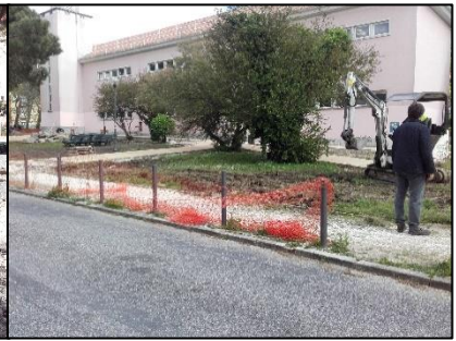
Fig.67- Obra: Colocação de bases
