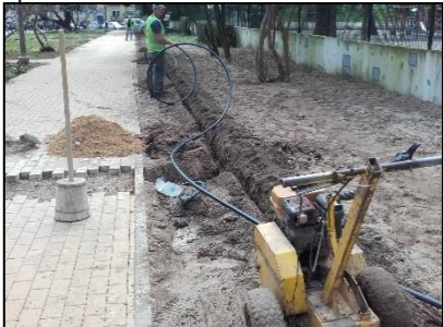
Fig.29- Obra: Execução de valas para rega
