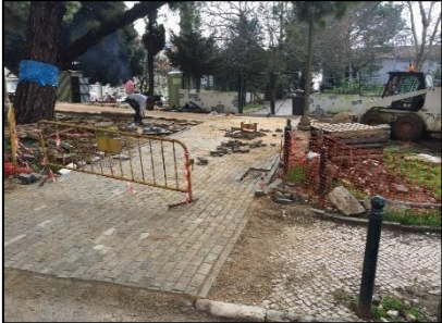
Fig.26- Obra: Colocação de pavimento - pavê
