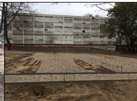
Fig.110- Obra: Zona de praça
