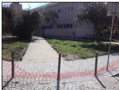
Fig.71- Obra: Colocação de pavimento
