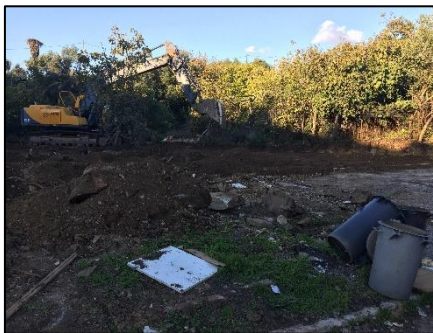
Fig.127- Obra: Limpeza do local
