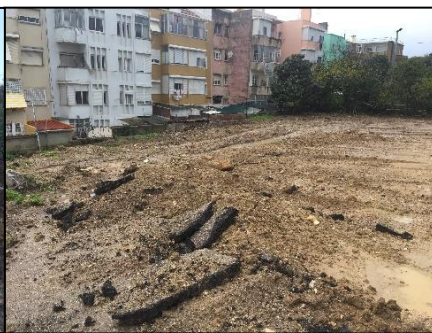
Fig.129- Obra: colocação do terreno às cotas
