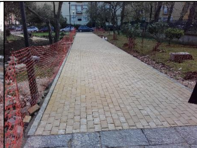
Fig.69- Obra: Colocação de pavimento
