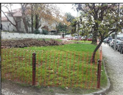
Fig.18- Obra: Remoção do pavimento
