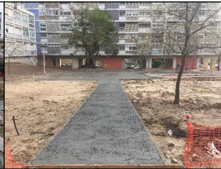
Fig.115- Obra: Acabamento estriado do betão
