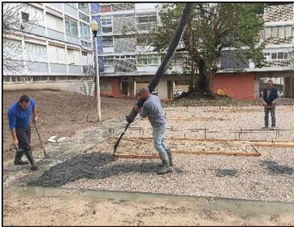
Fig.111- Obra: Betonagem da praça
