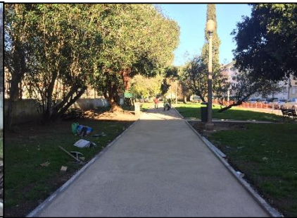
Fig.24- Obra: Base de assentamento em pó de pedra
