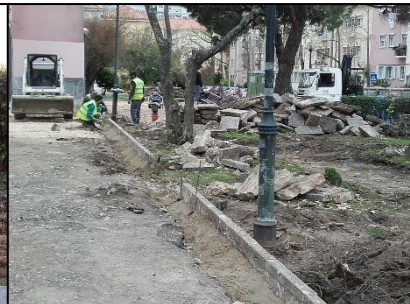
Fig.55- Obra: Execução de Lancil
