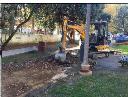
Fig.19- Obra: Remoção do betuminoso
