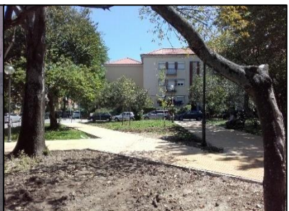
Fig.73- Obra: Colocação de bases
