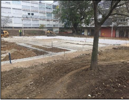
Fig.101- Obra: Execução da praça
