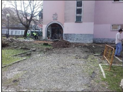
Fig.50- Obra: Remoção de Pavimento
