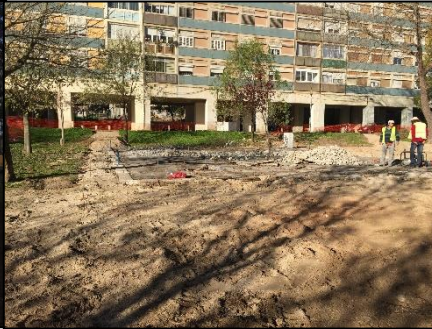
Fig.105- Obra: marcação de projeto
