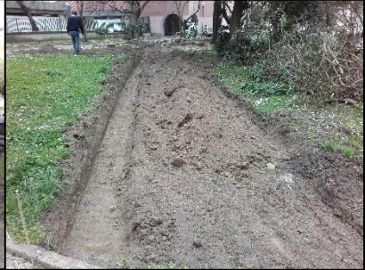
Fig.52- Obra: Caixa de Pavimento
