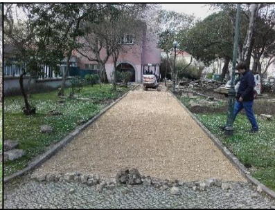
Fig.57- Obra: Colocação base pavimento
