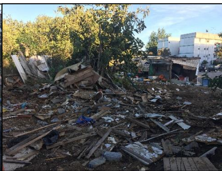
Fig.126- Obra: Demolições do existente
