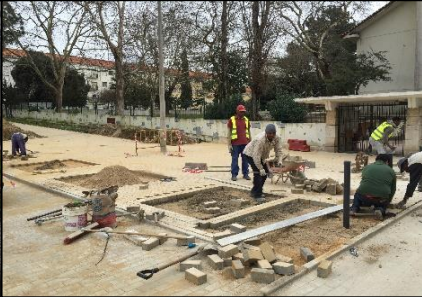
Fig.27- Obra: Execução de caldeiras
