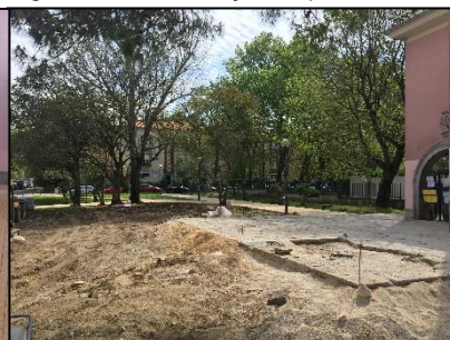
Fig.75- Obra: Colocação de lajes
