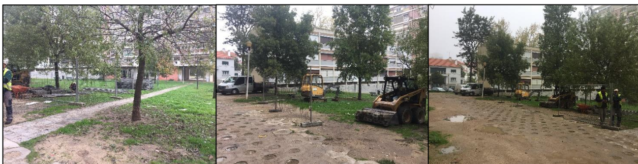
Fig.98- Obra: Zona de estaleiro
