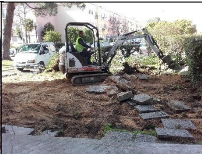
Fig.54- Obra: Remoção Lajes de Granito
