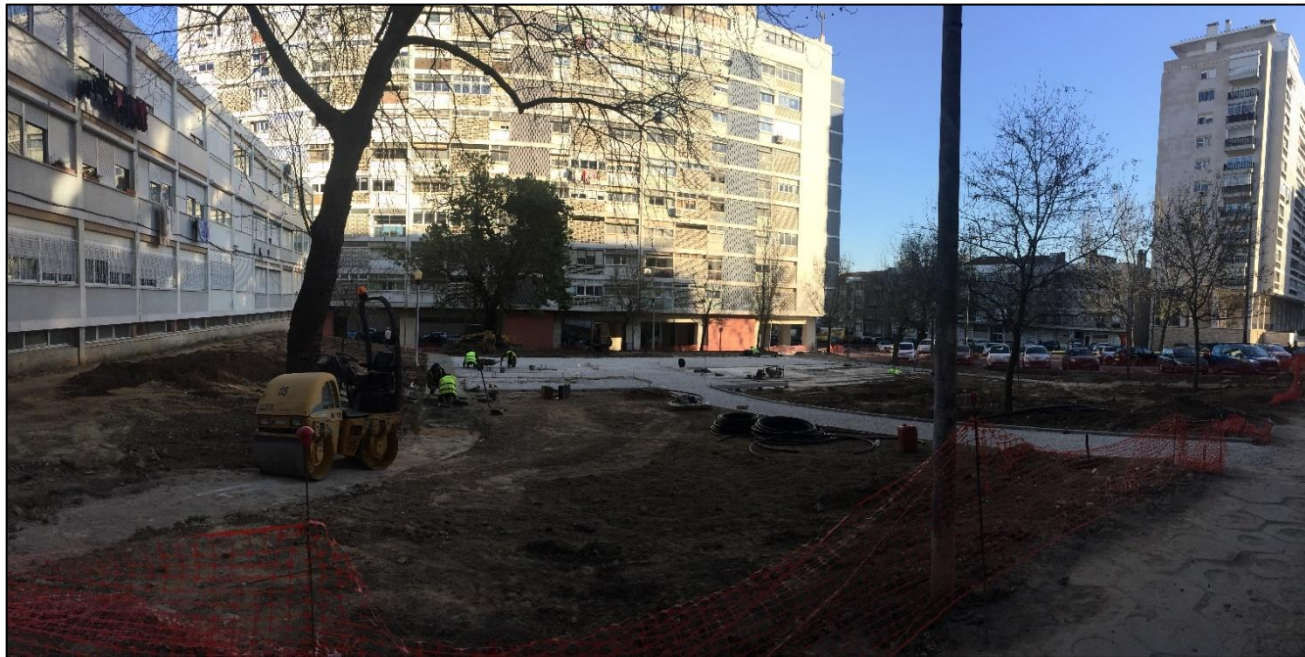
Fig.107- Obra: Execução de caminhos
