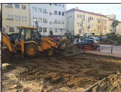
Fig.22- Obra: Remoção de betuminoso
