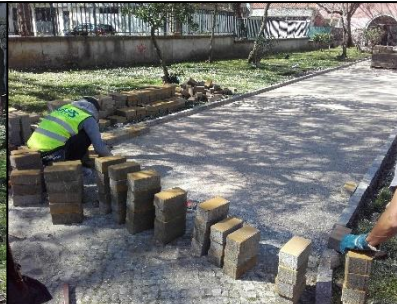
Fig.60- Obra: Colocação de pavimento
