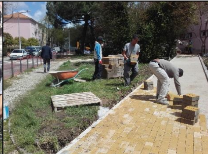
Fig.61- Obra: Colocação de pavimento
