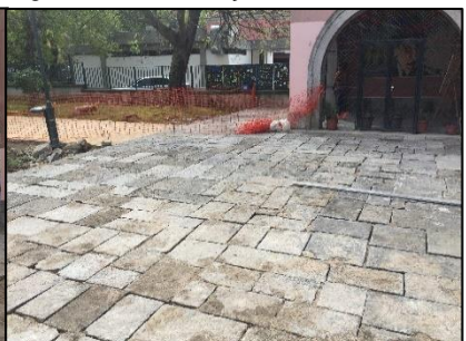
Fig.76- Obra: Colocação de lajes
