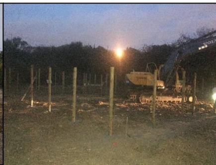
Fig.131- Obra: colocação de limites hortas
