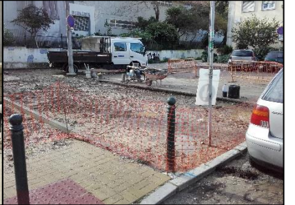
Fig.28- Obra: Execução de travessias pedonais
