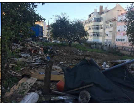
Fig.125- Obra: Demolições do existente
