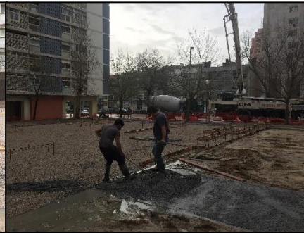
Fig.112- Obra: Betonagem da praça
