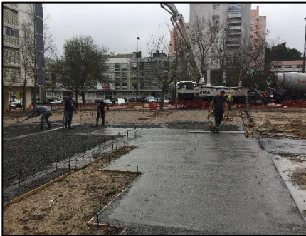
Fig.114- Obra: Betonagem da praça
