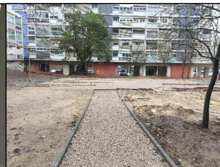
Fig.109- Obra: Lancil de betão
