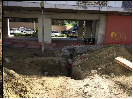
Fig.103- Obra: Vales de infraestruturas
