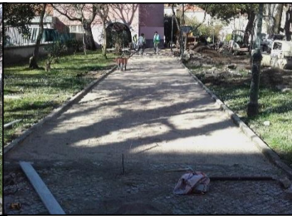
Fig.58- Obra: Base de assentamento
