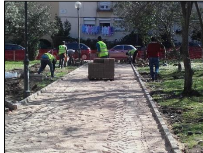
Fig.59- Obra: Colocação de pavimento
