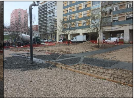
Fig.113- Obra: Betonagem da praça
