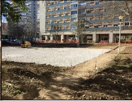
Fig.102- Obra: Bases de pavimento
