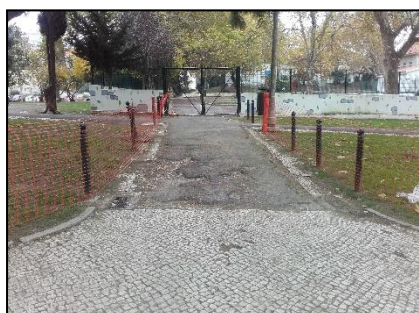
Fig.17- Obra: Vedação de obra
