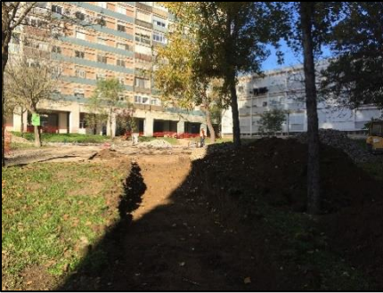
Fig.104- Obra: Marcação de caminhos
