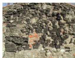
Figuras 7 e 8 – Alvenaria de cortiça.
