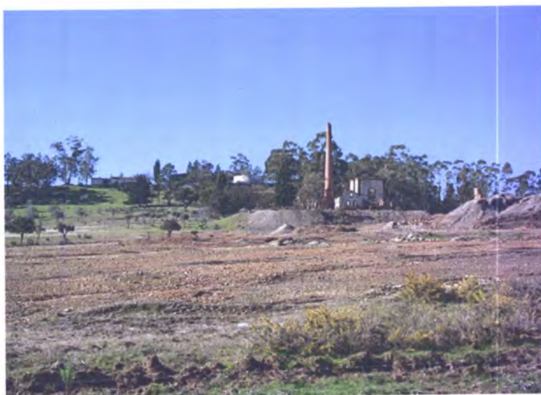
Figura 2.7. Vista panorâmica da zona de escombreira da mina da Herdade da Mostardeira. Ao fundo é possível observar as instalações mineiras, onde ficaria um poço de extracção (Rosado, 2005).
