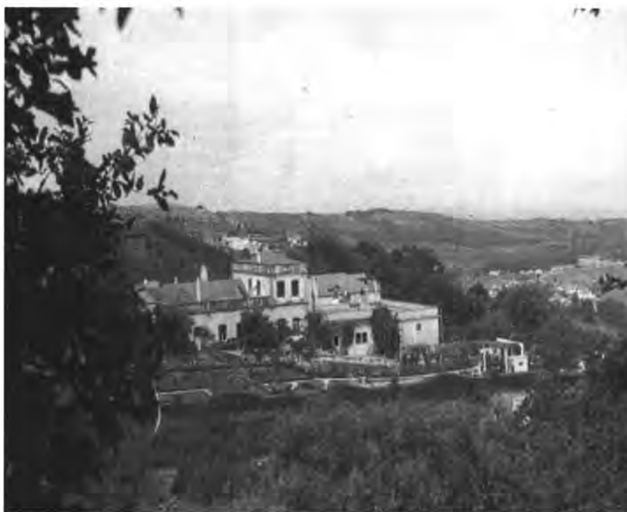
Fotografia 2: Vista geral da Quinta da Piedade em Colares.
