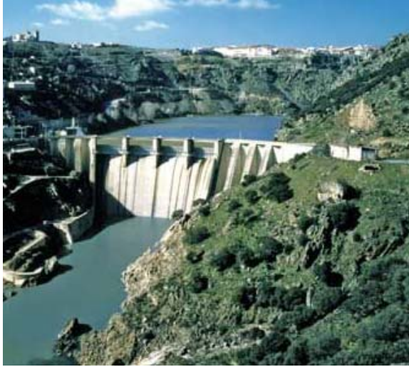
Figura 4.1. Barragem de contrafortes de Miranda (CNPGB).
