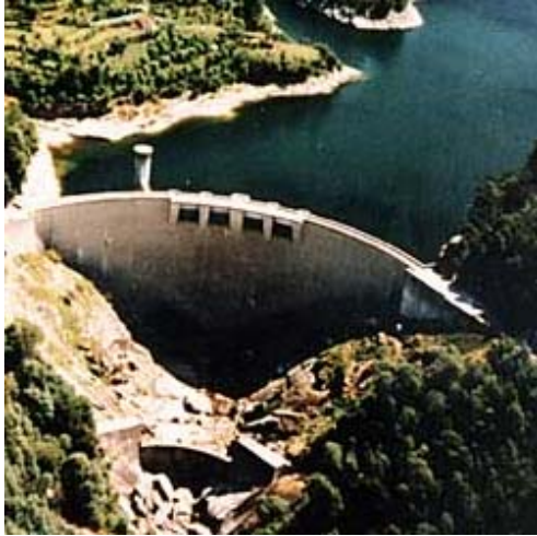
Figura 7.4 - Evacuador de cheias da Barragem de abóbada da Caniçada, do tipo orifício através de barragem (CNPGB).
