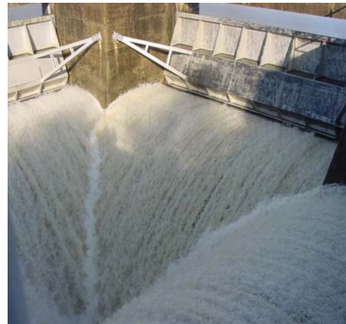
Figura 7.11 - Evacuador de cheias da Barragem de terra de Montargil, do tipo poço vertical, com controlo e com bacia de dissipação na parte terminal (CNPGB).
