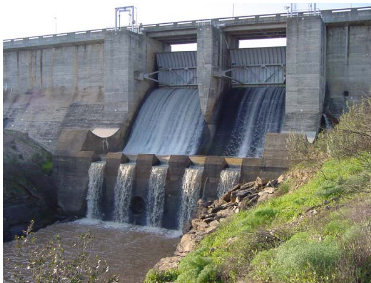
Figura 7.25 – Evacuador de cheias da Barragem do Monte Novo-Vista de jusante. Soleira WES com dois vãos equipados com comportas de segmento.
