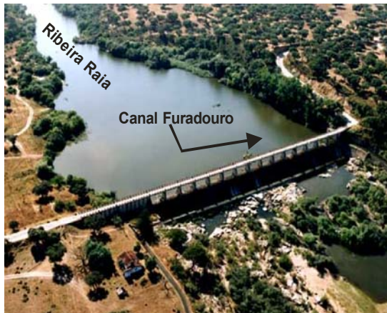
Figura 1.2. Barragem de gravidade do Furadouro, do tipo barragem descarregadora (açude) e de derivação (CNPGB).
