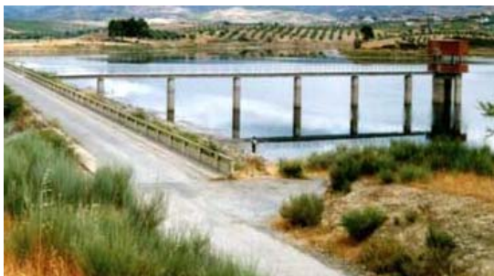
Figura 2.4. Barragem de terra homogénea com dreno de pé de jusante do Salgueiro (CNPGB).
