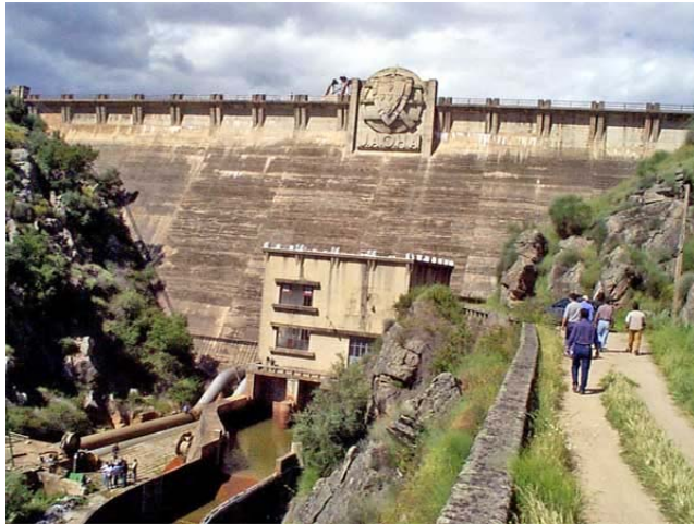
Figura 3.2. Barragem de gravidade de Idanha-a-Nova. Central de pé de barragem (CNPGB).
