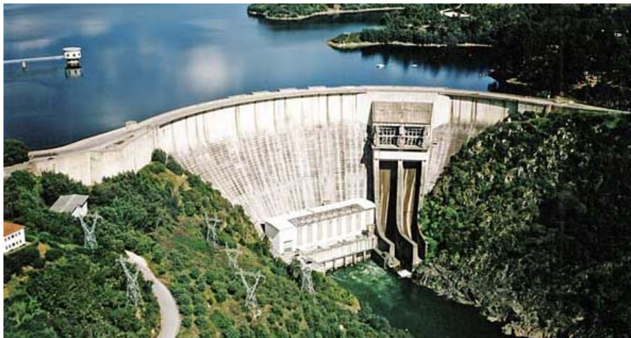
Figura 1.13. Panorâmica da Barragem de arco-gravidade de Castelo de Bode (CNPGB).
