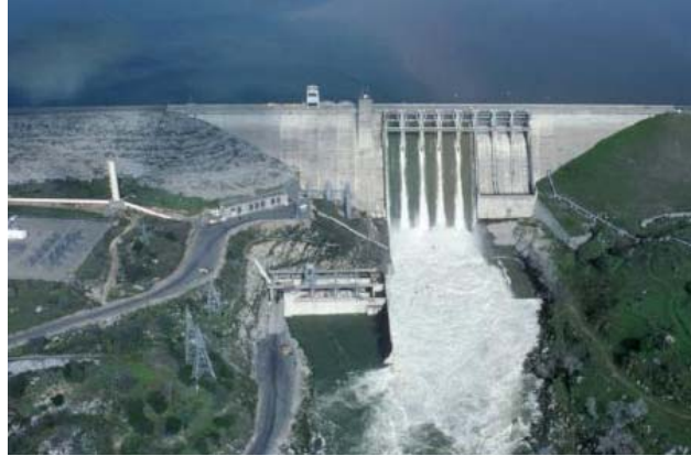
Figura 8.2. Evacuador de cheias sobre a barragem e terminando em bacia de dissipação, em funcionamento.
