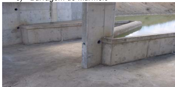
Figura 7.28 – Descarregadores em labirinto com módulos trapezoidais.
