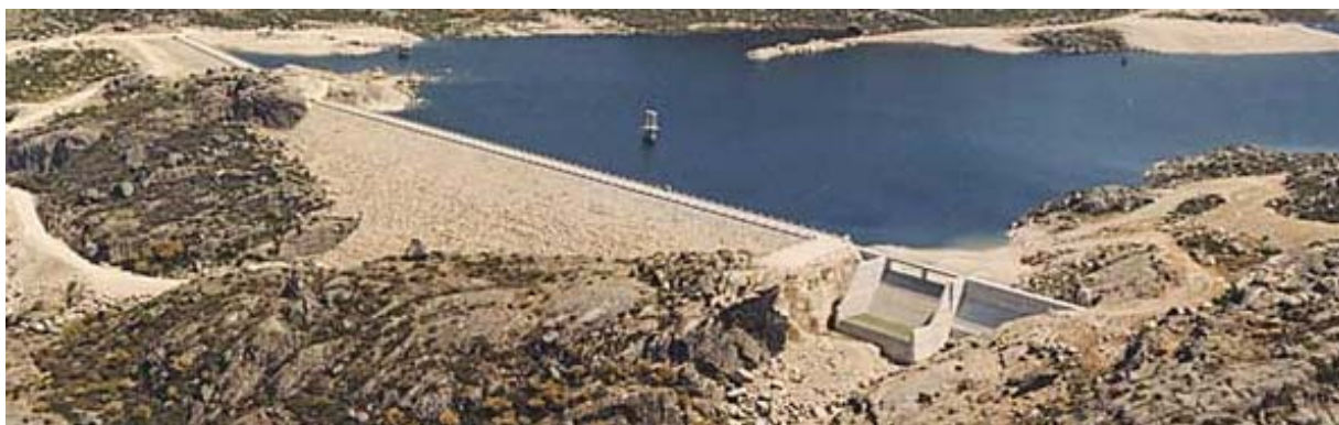
Figura 7.7 - Evacuador de cheias da Barragem de enrocamento de Lagoacho, do tipo canal a céu aberto, sem controlo com trampolim de saída (CNPGB).
