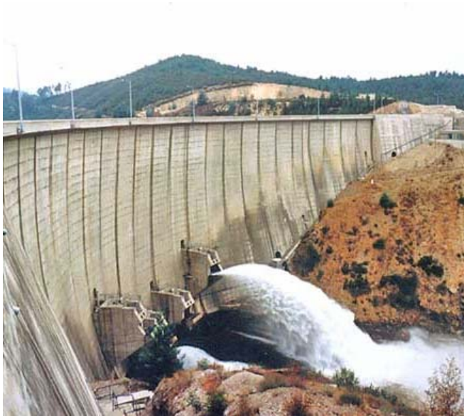
Figura 7.5 - Evacuador de cheias da Barragem de abóbada de Fronhas, do tipo orifício através de barragem (CNPGB).
