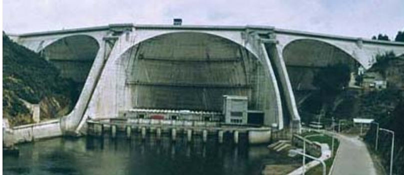
Figura 4.3. Barragem de abóbadas múltiplas (três) da Aguieira (CNPGB).
