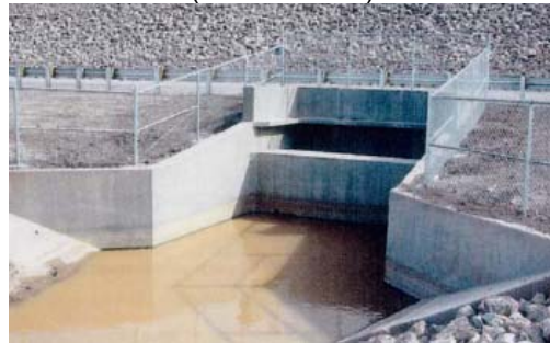
Figura 9.5 – Estruturas de jusante em descargas de fundo.
