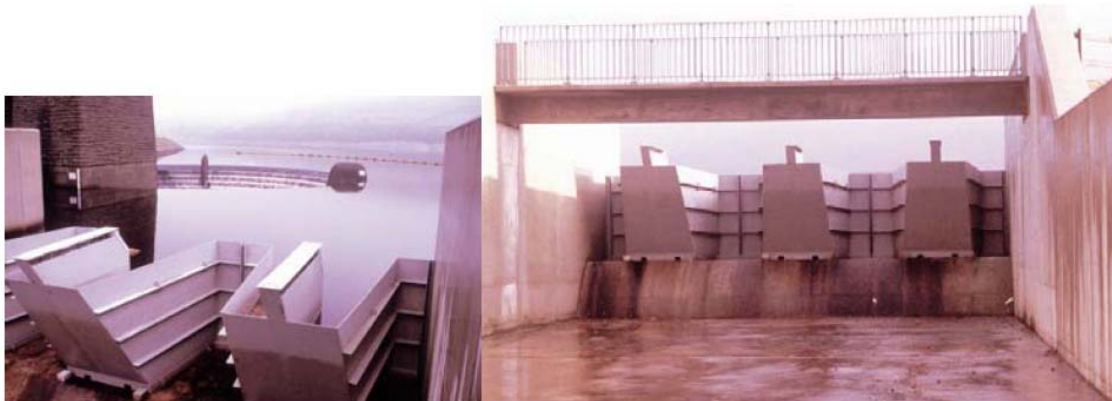
Figura 7.13 – Evacuador de emergência com comportas fusíveis da Barragem de Dove Stone (Pinheiro, 2006a).
