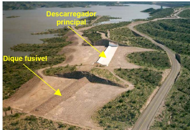
Figura 7.12 – Evacuador de emergência com dique fusível da Barragem de New Waddell (Pinheiro, 2006a).
