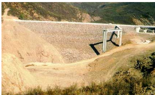
Figura 2.12. Barragem de terra e enrocamento com núcleo central de Alcoutim (CNPGB).
