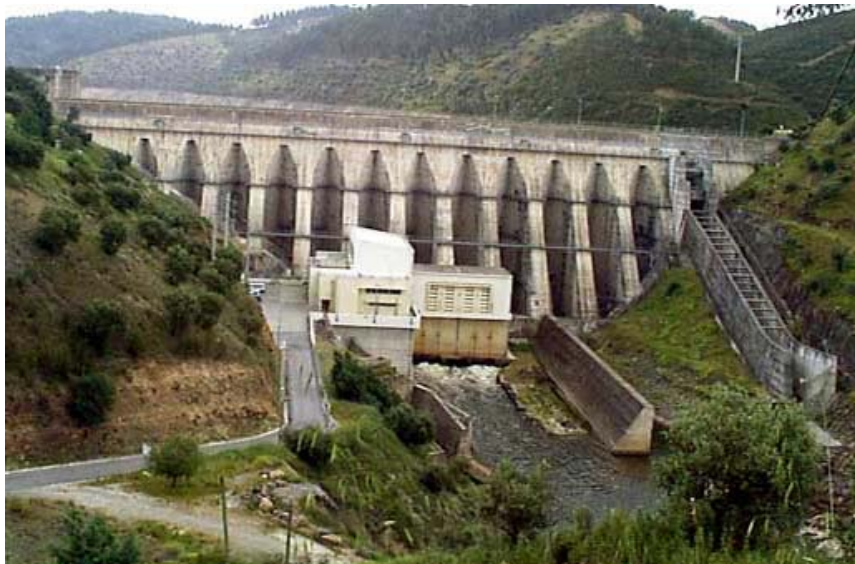
Figura 1.17. Panorâmica de uma barragem de contrafortes (barragem da Pracana, CNPGB).
