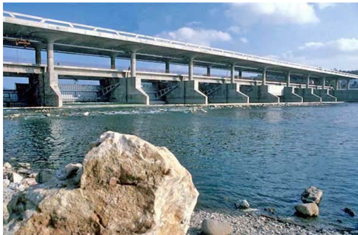
Figura 3.3. Barragem descarregadora (ou açude) móvel de Coimbra (CNPGB).
