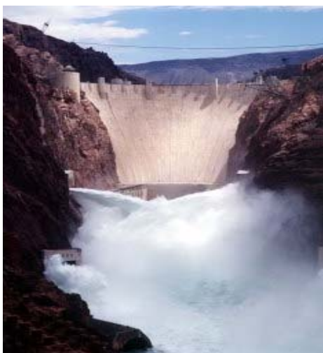
Figura 7.6 - Evacuador de cheias do tipo orifício com jactos cruzados.
