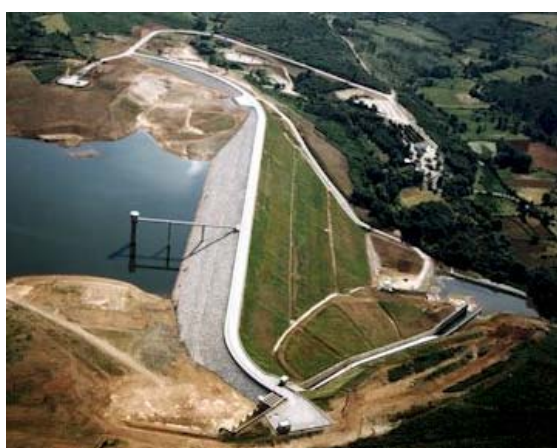
Figura 7.9 - Evacuador de cheias da Barragem de terra do Sabugal, do tipo canal a céu aberto sobre a encosta, sem controlo e com bacia de dissipação na parte terminal (CNPGB).
