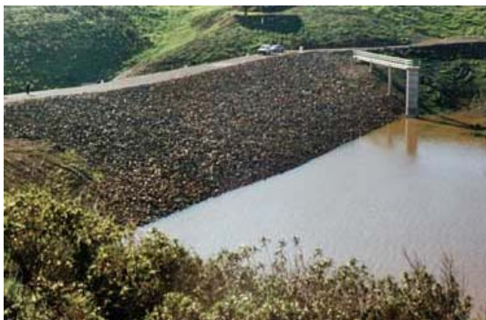
Figura 2.2. Barragem de terra homogénea da Caroucha (CNPGB).
