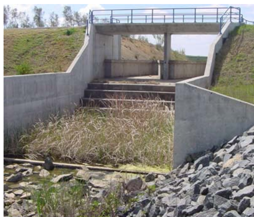
Figura 7.10 - Evacuador de cheias com canal em degraus de uma pequena barragem de terra e evacuador da Barragem do Marmelo, com descarregador em labirinto, canal em degraus e bacia de dissipação.
