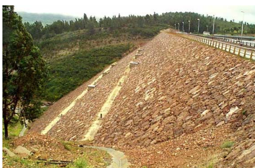
Figura 2.16. Barragem de enrocamento com cortina de betão a montante da Apartadura (CNPGB).
