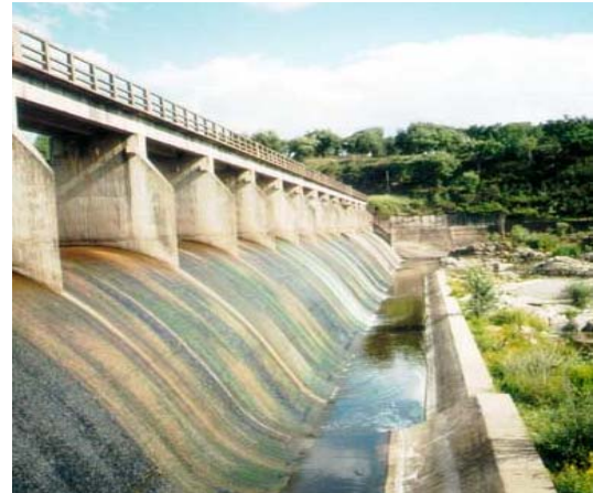
Figura 1.2. Barragem de gravidade do Furadouro, do tipo barragem descarregadora (açude) e de derivação (CNPGB).
