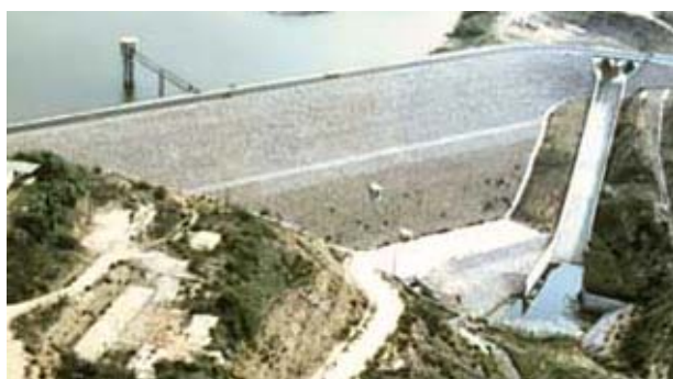
Figura 7.14 - Evacuador de cheias da Barragem de enrocamento de S. Domingos, do tipo canal a céu aberto, sem controlo e com bacia de dissipação de energia (CNPGB).
