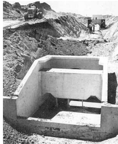
Figura 8.13. Bacia de dissipação por impacto, USBR tipo VI.
