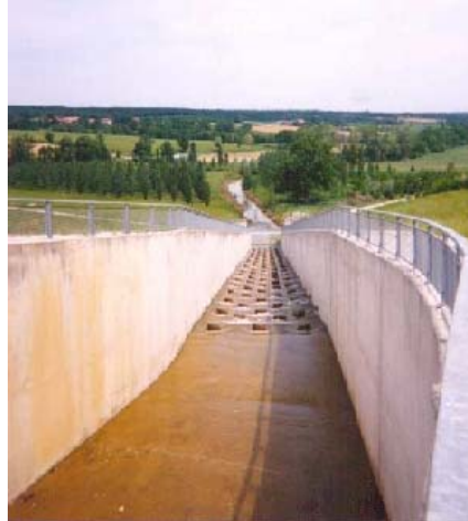
c) Proporções de uma rampa de dissipação de energia com macrorugosidades (USBR, 1974)
