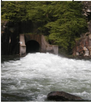
Figura 9.5 – Estruturas de jusante em descargas de fundo.
