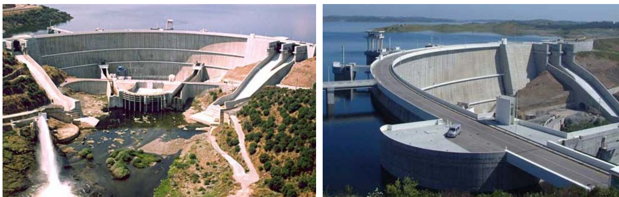
Figura 7.8 - Evacuador de cheias da Barragem de abóbada do Alqueva, do tipo canal a céu aberto, com controlo e com trampolim de saída (CNPGB).
