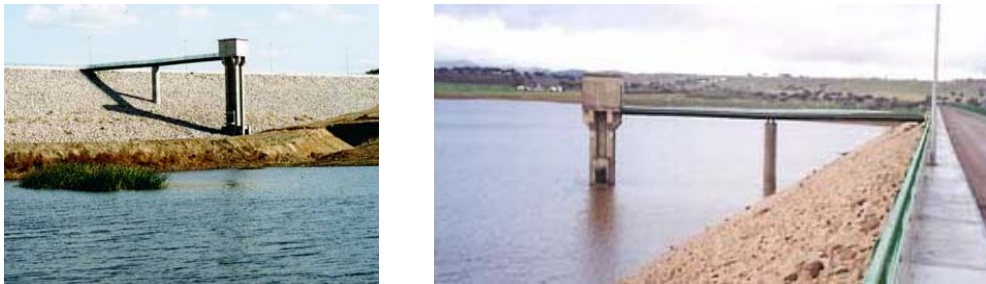
Figura 9.1 – Torre da tomada de água da Barragem de Abrilongo (CNPGB).
