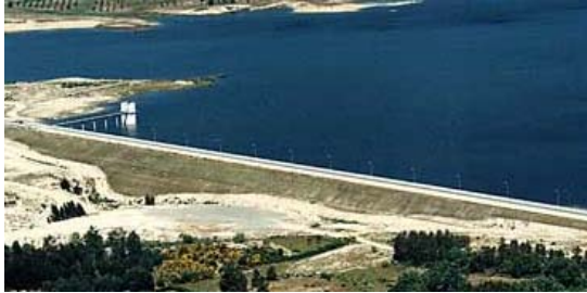
Figura 2.8. Barragem de terra homogénea com tapete drenante e dreno chaminé inclinado da Marateca (CNPGB).
