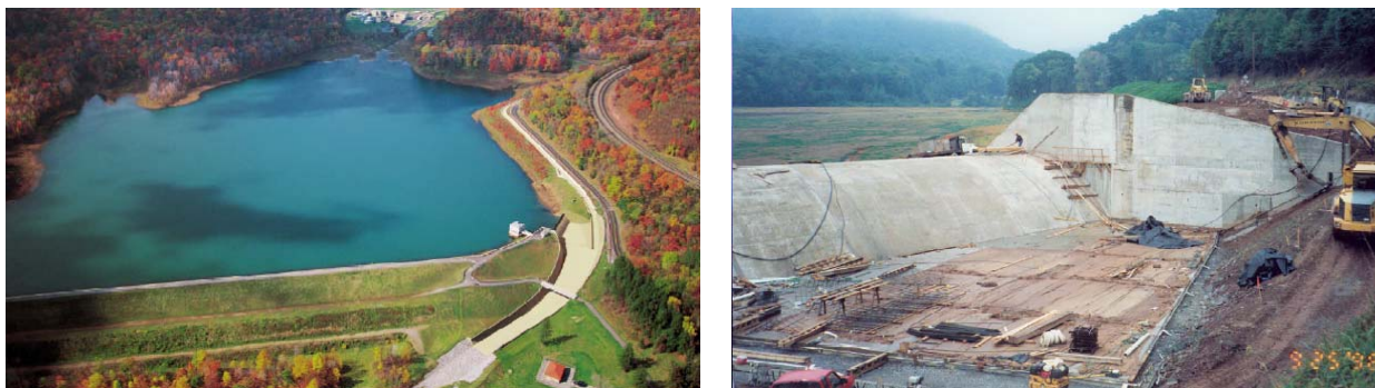
Figura 7.38 – Evacuador de cheias da Barragem de terra de Altona, do tipo descarregador lateral – canal coletor.
