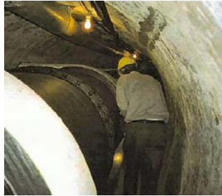
Figura 9.4 – Galeria de acesso à conduta, no caso do controlo intermédio com acesso por jusante (FEMA, 2005b).
