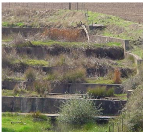
Figura 7.10 - Evacuador de cheias com canal em degraus de uma pequena barragem de terra e evacuador da Barragem do Marmelo, com descarregador em labirinto, canal em degraus e bacia de dissipação.
