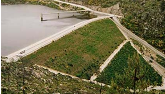
Figura 2.10. Barragem de terra zonada com tapete drenante e dreno chaminé inclinado do Alijó (CNPGB).
