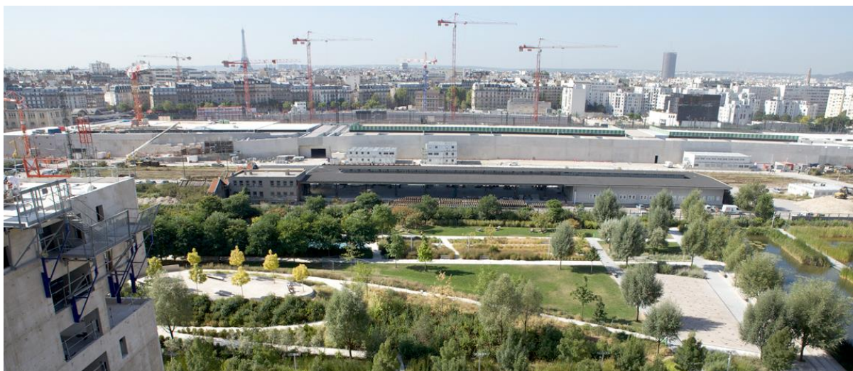
32. Primeiro parque inaugurado em 2007 e a cobertura das atividades ferroviárias, em construção. Fonte: PBA, 2012.
