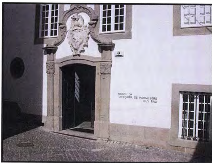
Figura 3.2.1.1 - Fachada principal do museu
