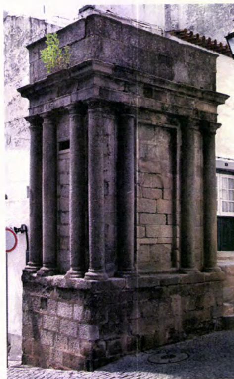
Fig. 78 Caixa de água da Rua Nova (Foto: F. Bilou)
