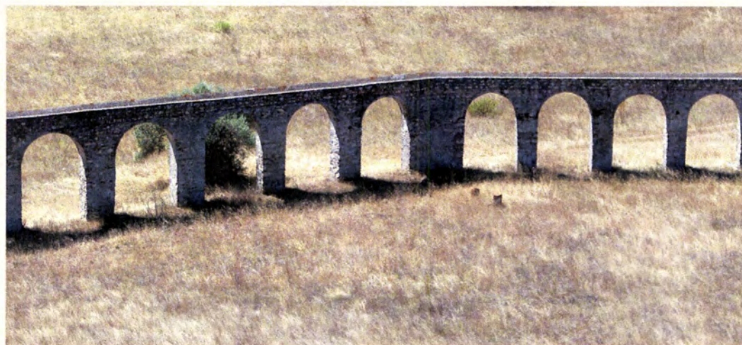
Fig. 14 Vista aérea sobre o Aqueduto, troço S. Bento de Cástris -Torralva (Foto: F. Bilou)
