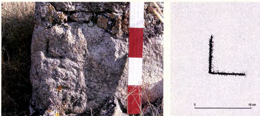
Fig. 17 Marca de acerto em bloco de pedra reaproveitado
