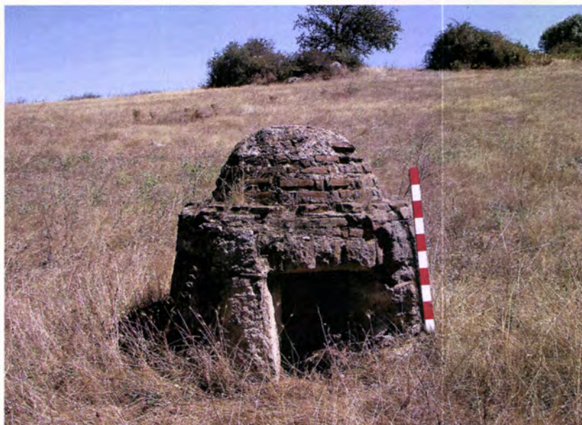
Fig. 41 Caixa de ventilação do Aqueduto do séc. XVI. Herdade de Ximenes (Graça do Divor).
