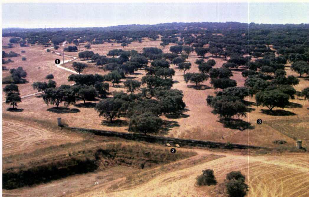
Fig. 11 Vista aérea do local onde provavelmente se situariam os "Arcos do Divor", sob o actual traçado do Aqueduto (Foto: F. Bilou)
