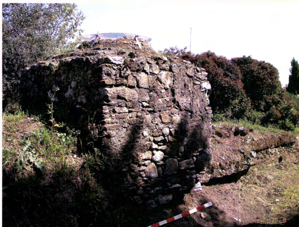
Fig. 42 Caixa de visita e decantação do Aqueduto do séc. XVI. Quinta do Serrado (Valcovo).
