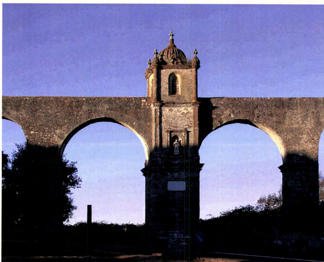
Fig. 27 Arcaria monumental do Aqueduto à passagem da estrada de Arraiolos
