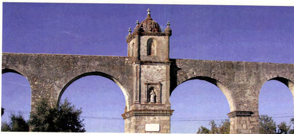
Fig. 69 Torrinha do pilar central da arcaria do Aqueduto à estrada de Arraiolos
