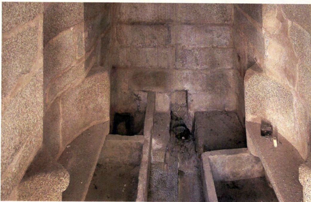
Fig.82 Interior da caixa de água da Rua Nova
