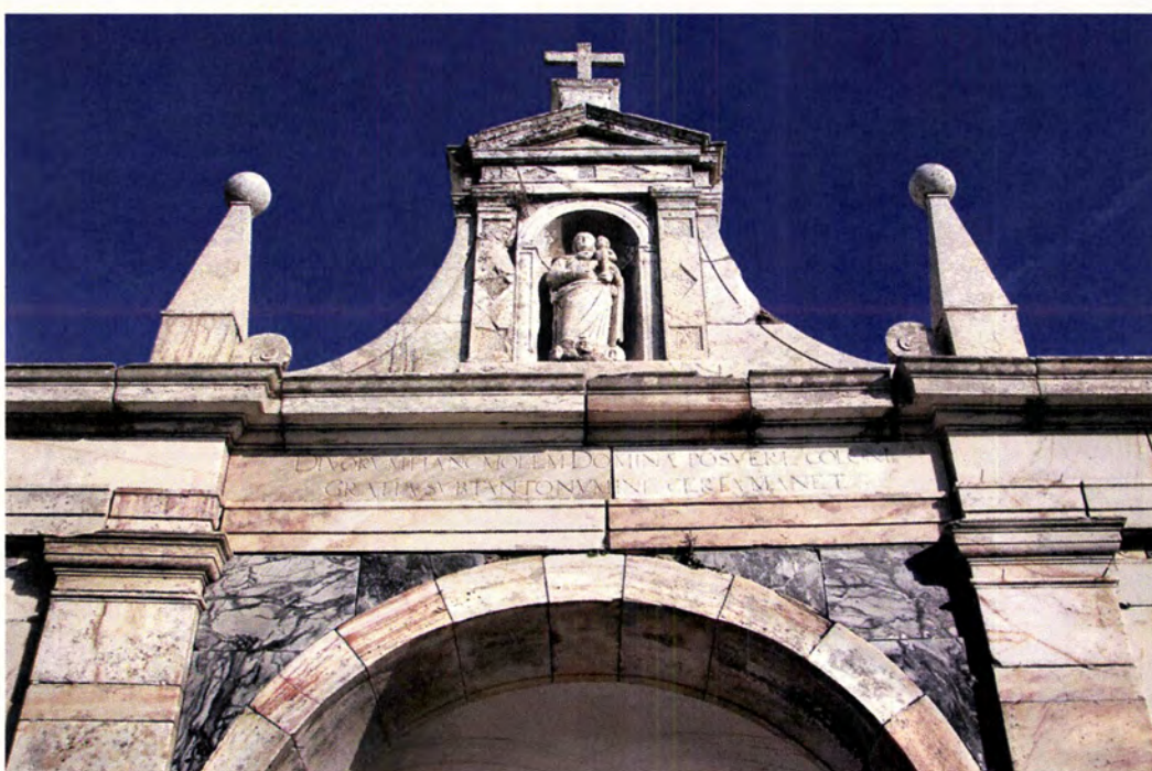
Fig. 4 Fachada de Nossa Senhora da Graça do Divor (Foto: F. Bilou)
