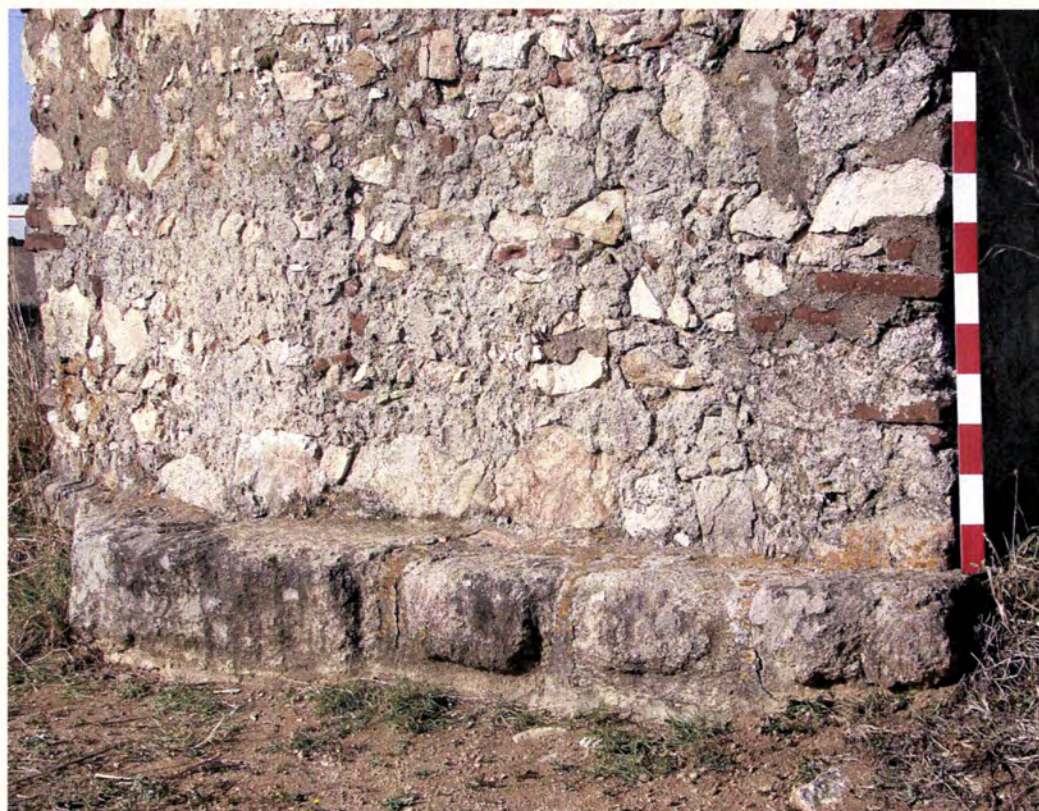
Fig. 18 Base de pilar com vestígios de opus quadratum
