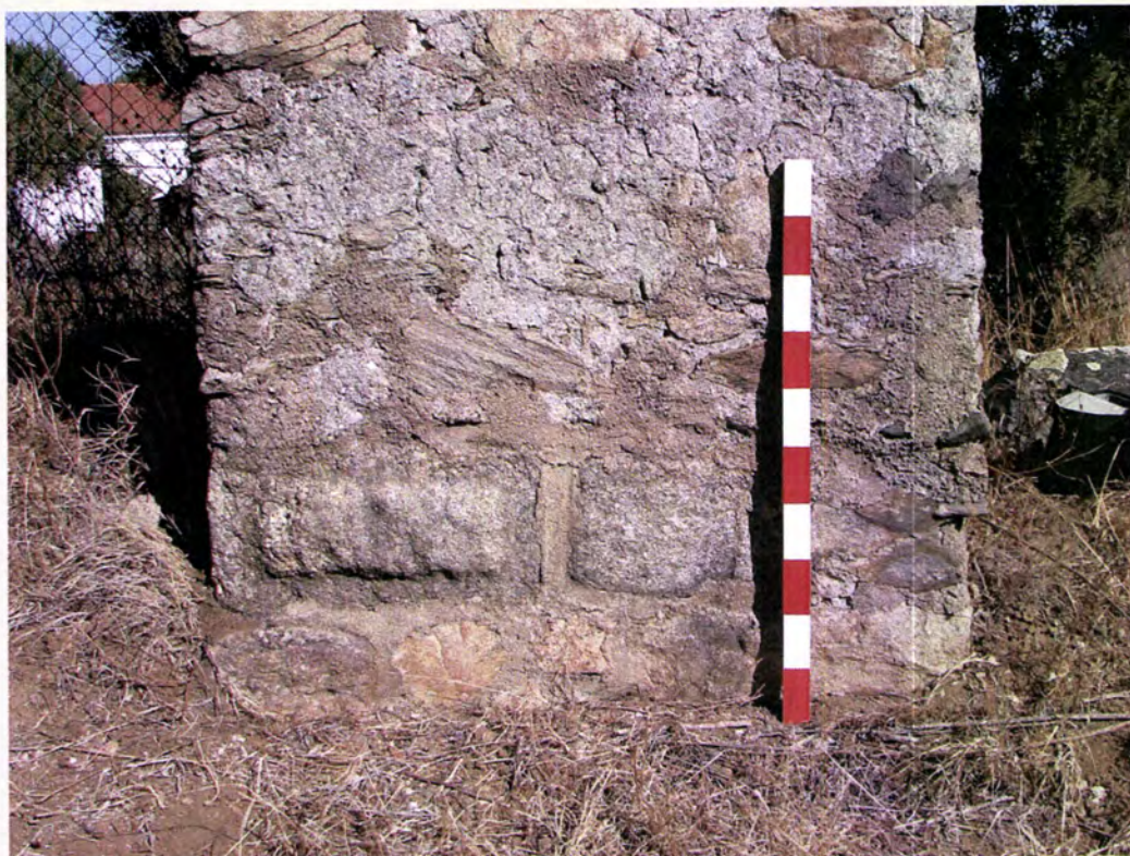
Fig. 19 Silhar almofadado num pilar do Aqueduto
