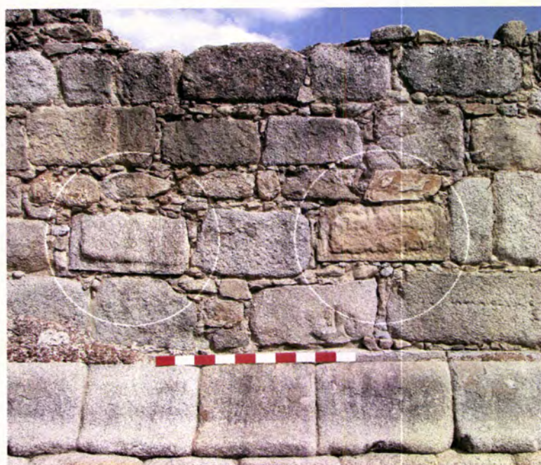
Fig. 19 Silhar almofadado num pilar do Aqueduto
