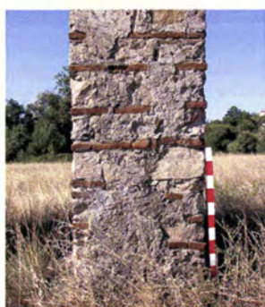
Fig. 55 Pilar do Aqueduto
