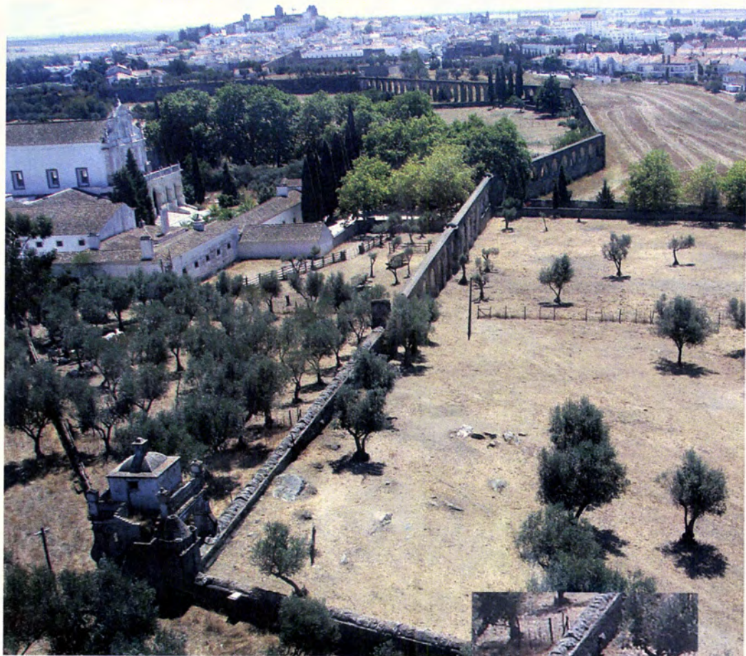
Fig. 21 Vista aérea do Aqueduto na zona da caixa de água da Cartuxa. Pormenor dos "pegões" com recurso a contraste cromático (Foto: F. Bilou).
