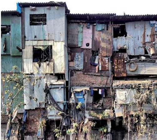
[FIG.57] Construção em chapas metálicas
