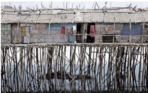
[FIG.58] Construção em Bamboo
