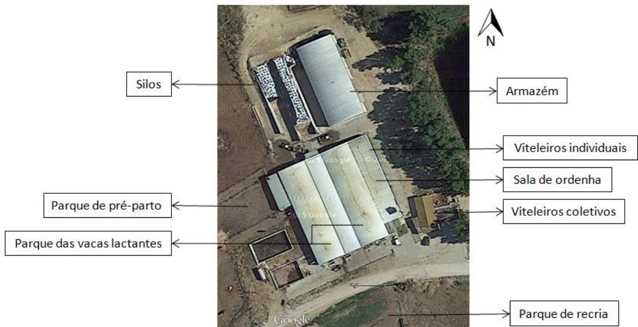
Figura 7 - Vista aérea da das instalações da exploração (Herdade das Pedras Alvas, Montemor-o-Novo, 2015).
