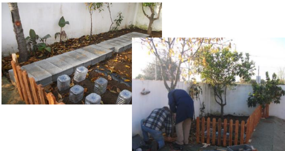
Figura 42 Colocação da vedação da horta.
