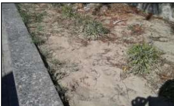
Figura 205 – Estado dos canteiros
