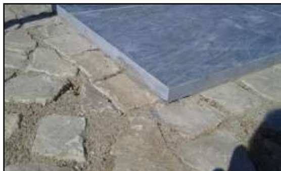
Figura 222 – Pavimento em mármore
