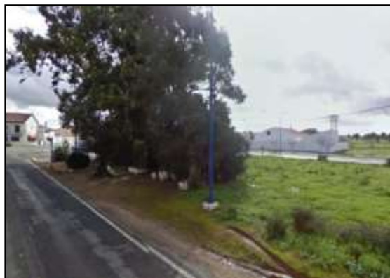
Figura 153 – Estrada Nacional antes de ser intervencionada
