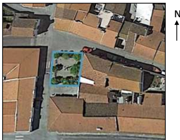
Figura 106 – Fotografia aérea do espaço aberto junto ao Pelourinho
