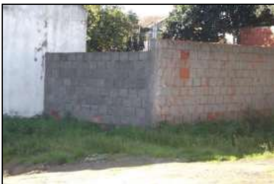
Figura 166 – Muro em alvenaria
