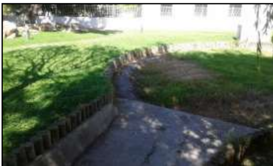
Figura 226 – Elemento de água inactivo
