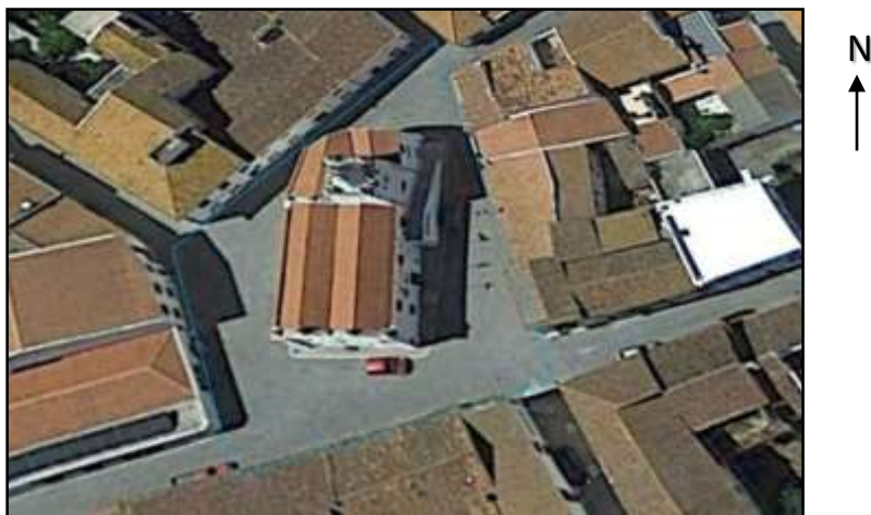
Figura 86 – Fotografia aérea do edifício da câmara
