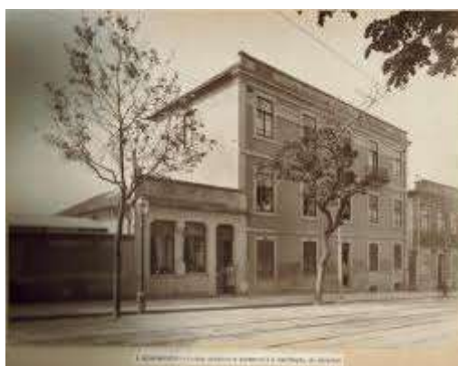
Ilustração 6 Edifício do Conservatório de Música do Porto no Carregal em 1917. Fonte: http://portofofotos.blogspot.pt/2011_03_21_archive.html consultado a 23/07/2012
