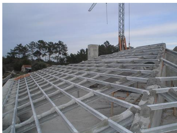
Figura 33 – Exemplo de cobertura em betão, Fonte: SPRAL
