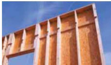
Figura 36– Exemplo de Colocação de Placas OSB, Fonte : www.jular.pt
