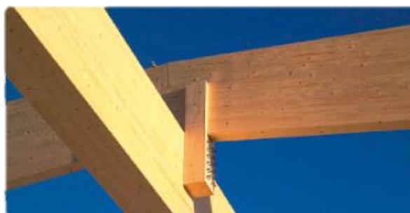
Figura 15 - Vigas de madeira lamelada colada Fonte: www.jular.pt
