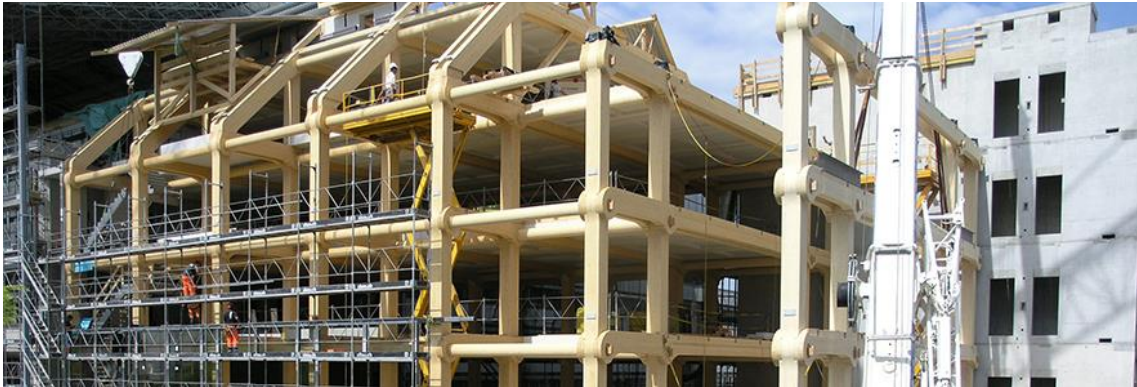
Figura 5- Edifício Tamedia em Construção, Fonte : www.swissinfo.ch
