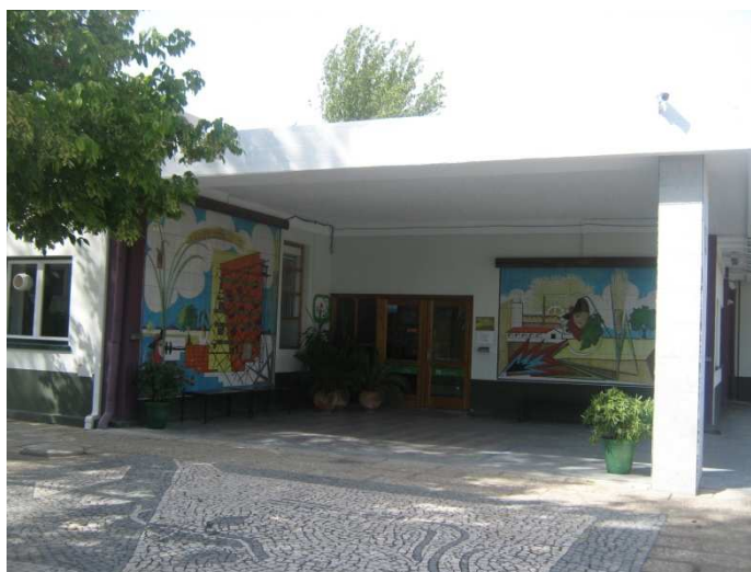
Figura 6 – Entrada do C.F.E
