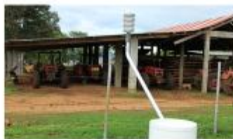
Vedação inapropriada (FATUMACA)
