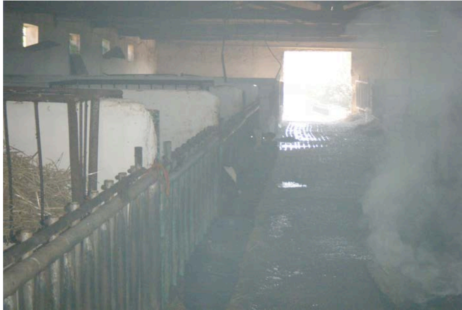
Imagem nº 19 – Pavilhão onde se encontrava o viteleiro. É notória a má ventilação, após um teste feito pelo MV para gerar algum fumo, mostrando ao proprietário que o ar era muito pouco renovável.
