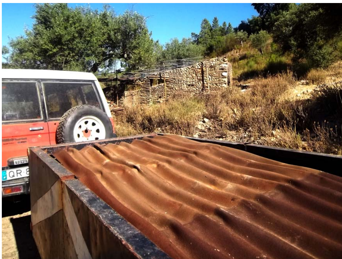
i174. Chapas de onduline antes de serem descarregadas. Estas placas tinham sido retiradas do telhado do lagar, recentemente remodelado, onde funcionavam como sub-telha.
