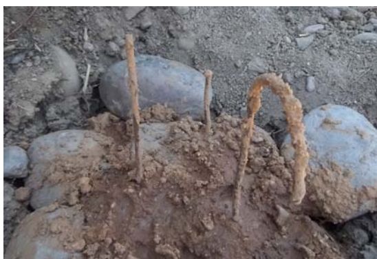
i164. Espigões já chumbados no solo.
