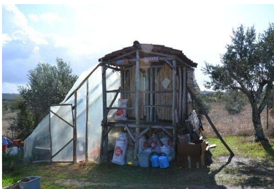
i96. Gestão da água Casas de banho secas. Ecovillage de Tribodard, fundada em 2009-2010 perto de Nisa, Alto Alentejo.
