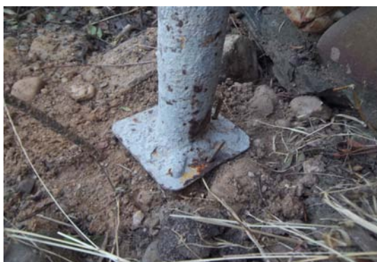
i165. Pilar encaixado nos espigões. O pilar é uma escora extensível em ferro.
