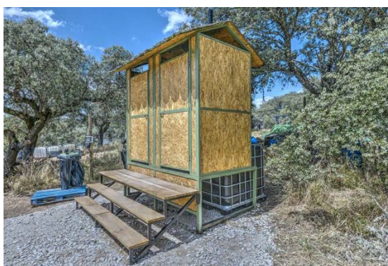
i71. Boom, protótipo de casa de banho seca (2014).
