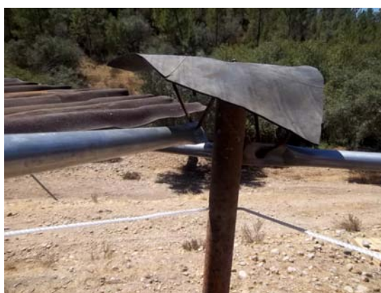
i173. Capa executada em câmara de ar de tractor para não ferir o apoio das chapas de onduline.
