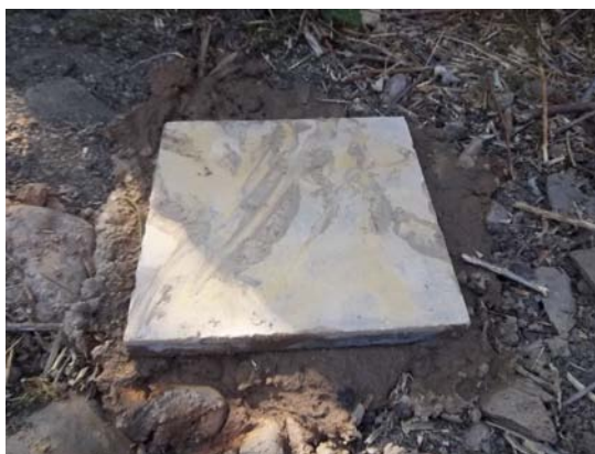
i159. Teste de fixação do primeiro mosaico de pavimento com recurso a barro extraído da charca.
