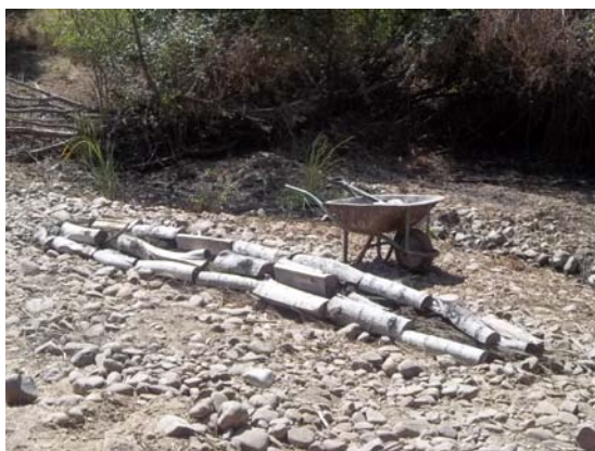
i185. Cama em construção.
