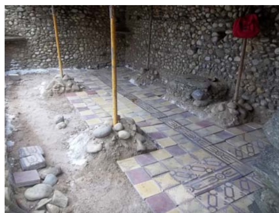
i181. Aplicação dos mosaicos de pavimento, inspirado no desenho prévio. Não se limitou a uma mera execução da norma do desenho pois as faces dos mosaicos, por conterem restos de cimento, aderiam de forma diversa mesmo sendo do mesmo padrão. Tornou-se na execução de um puzzle com a solução final em aberto.
