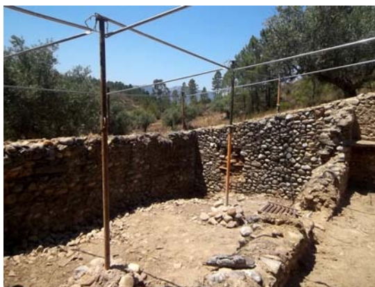
i167. Dezasseis pilares em escoras extensíveis, vinte e quatro vigas em travessas de andaime, quarenta e oito grampos de amarração.
