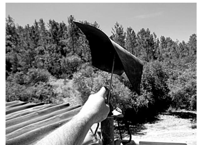
15. Protecção dos topos dos pilares com câmara-de-ar de tractor.
