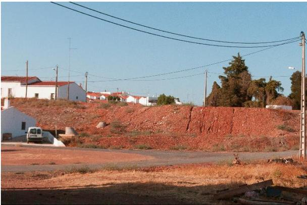
**Figura 6.17** – Material depositado em aterro na zona da aldeia (classe EA).
