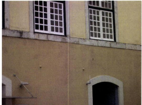
Fig. 86 - Pormenor dos pontos de ancoragem, fachada nascente - 05/09/2006
