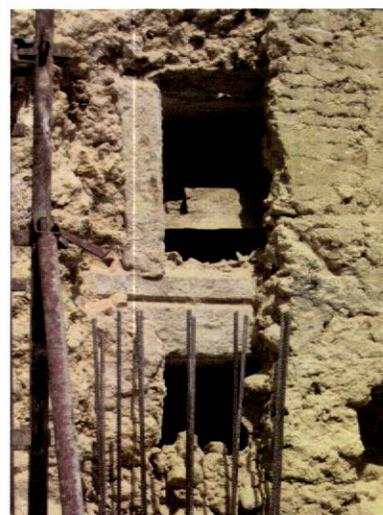
Fig. 40 - Pormenor da constituição da parede - 13/07/2006, Imagem cedida pela U.Lusófona
