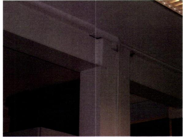
Fig. 92 - Pormenores do reforço de vigas e pilares - 05/09/2006
