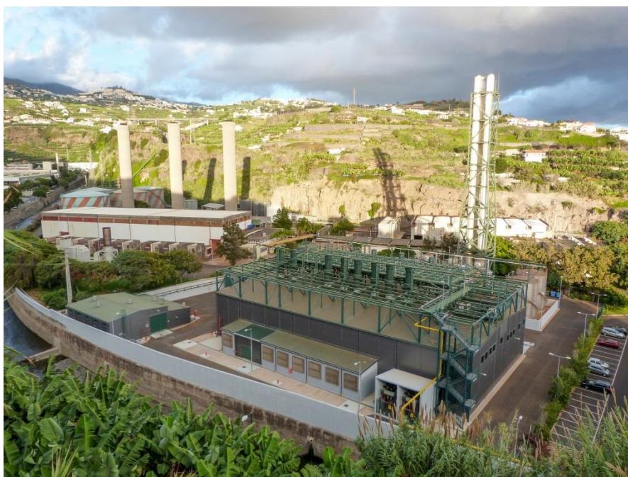
Imagem 109: Central Termoeletrica da Vitória - Ribeira dos Socorridos (DR). Zona de alta fragilidade visual devido à grande impermeabilização e ocupação desorganizada.
