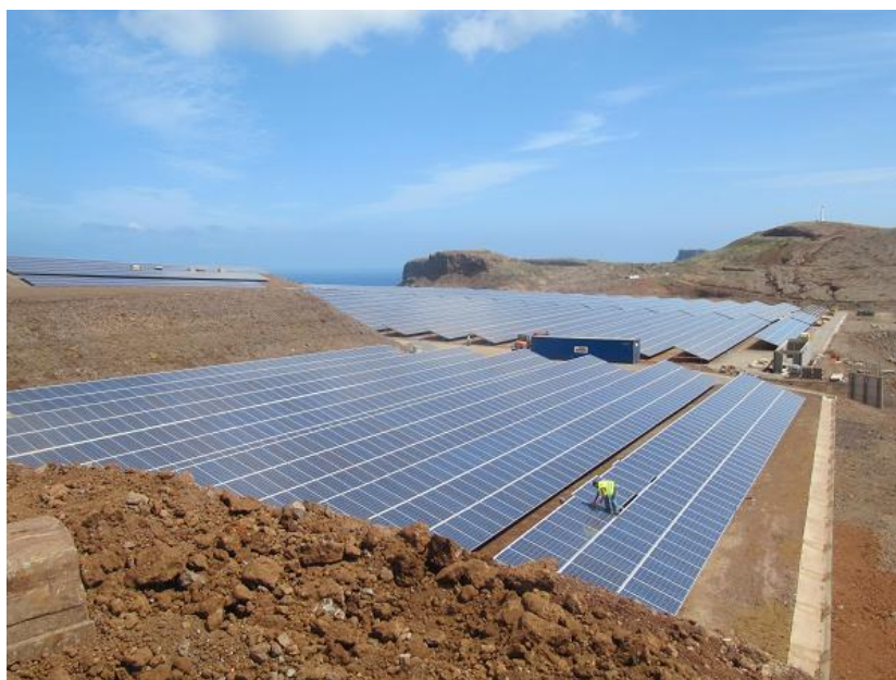
Imagem 100: Instalação de painéis fotovoltaicos no Parque do Caniçal. (Output Energias e Ambiente, Lda. - 2009)
