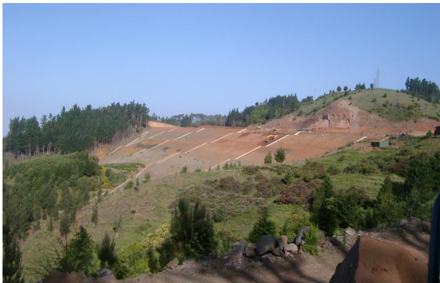
Imagem 113: Aterro da Fundação Social Democrata – Achada Grande (PS).
