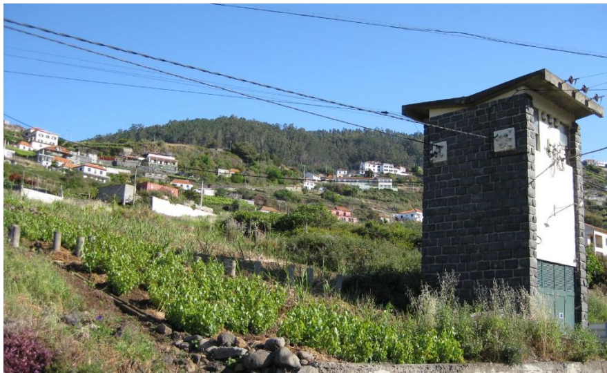
Imagem 115: Campanário – Concelho da Ribeira Brava (PS). Impacte visual associado aos inúmeros cabos elétricos aéreos.
