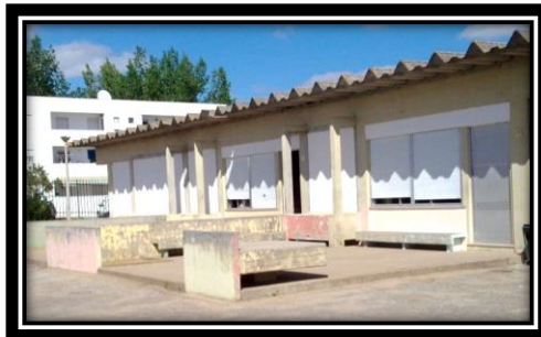
Figura 10 - Espaço exterior do pavilhão B (Escola Básica André de Resende).
