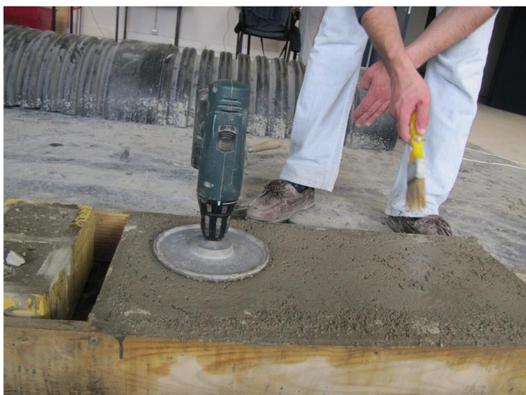
Figura 12 – Protótipo afagador utilizado
