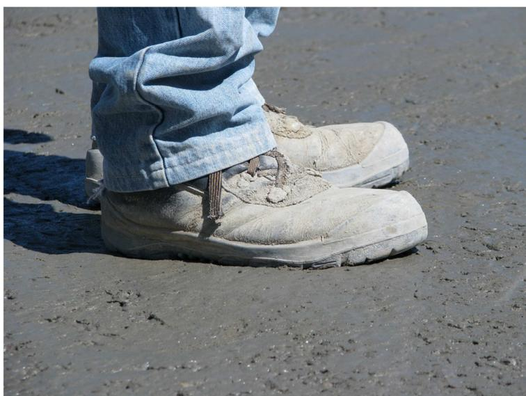
Figura 1 – Profundidade de penetração da bota de um trabalhador
