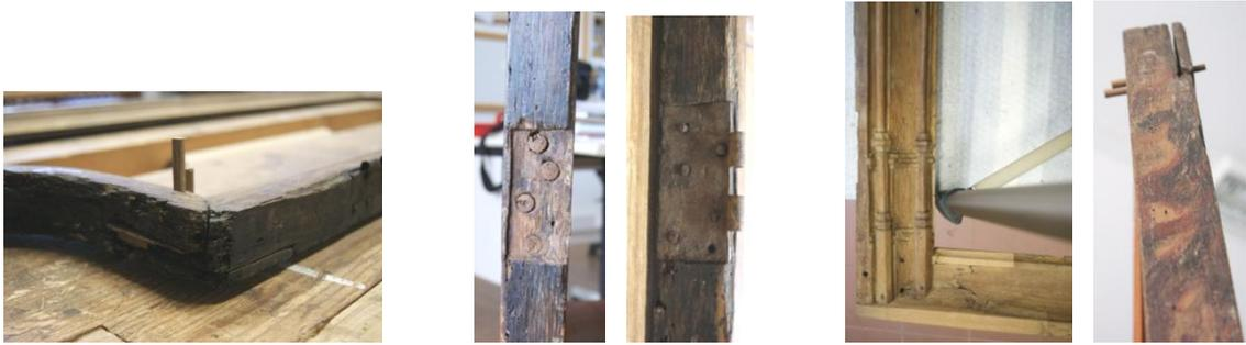
Figs.4.54a,b a Cavilhas nos cantos da moldura b dobradiça original
